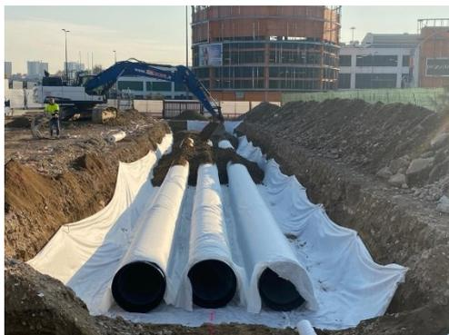
Realizzando sempre delle trincee, ma posizionando delle tubazioni di grosso diametro come in figura, verrebbe sfruttata ugualmente la capacità di infiltrazione del sottosuolo ma implicherebbe la realizzazione di grosse cubature di scavo, risultando in sostanza molto meno efficace che un sistema pozzi.
