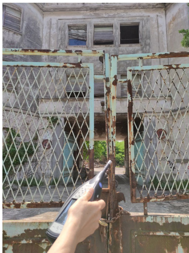
Ingresso principale via Lepanto via Rivarolo
