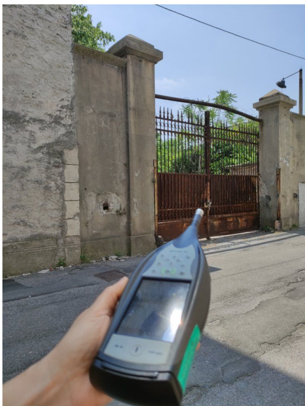
Ingresso Via Lepanto
