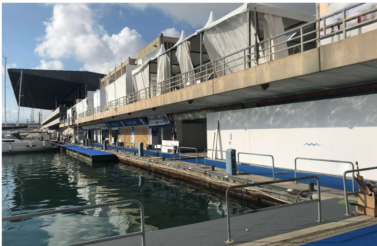
Vista delle banchine da quota +1.00 s.l.m.
