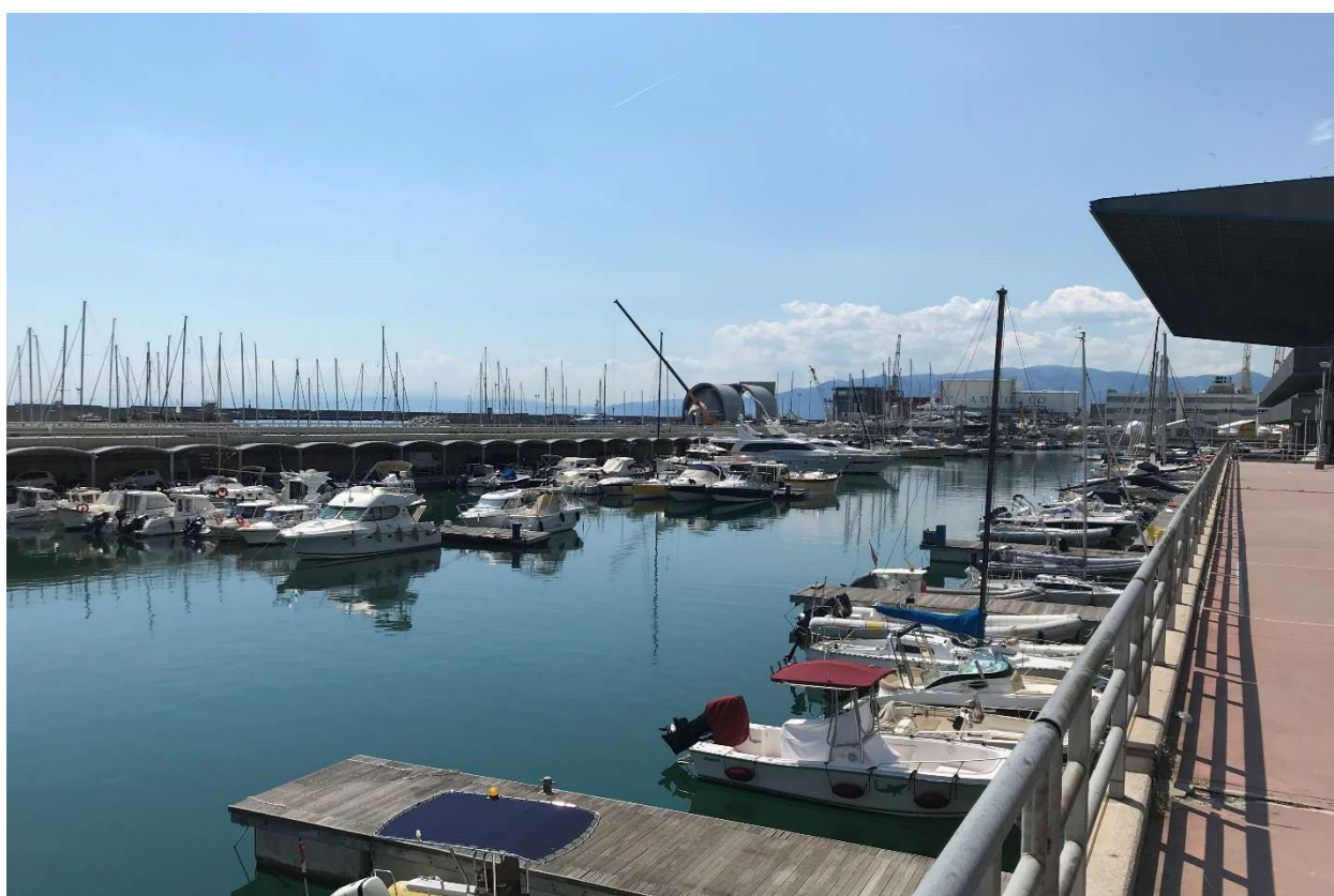
Vista delle banchine da quota +5.50 s.l.m.
