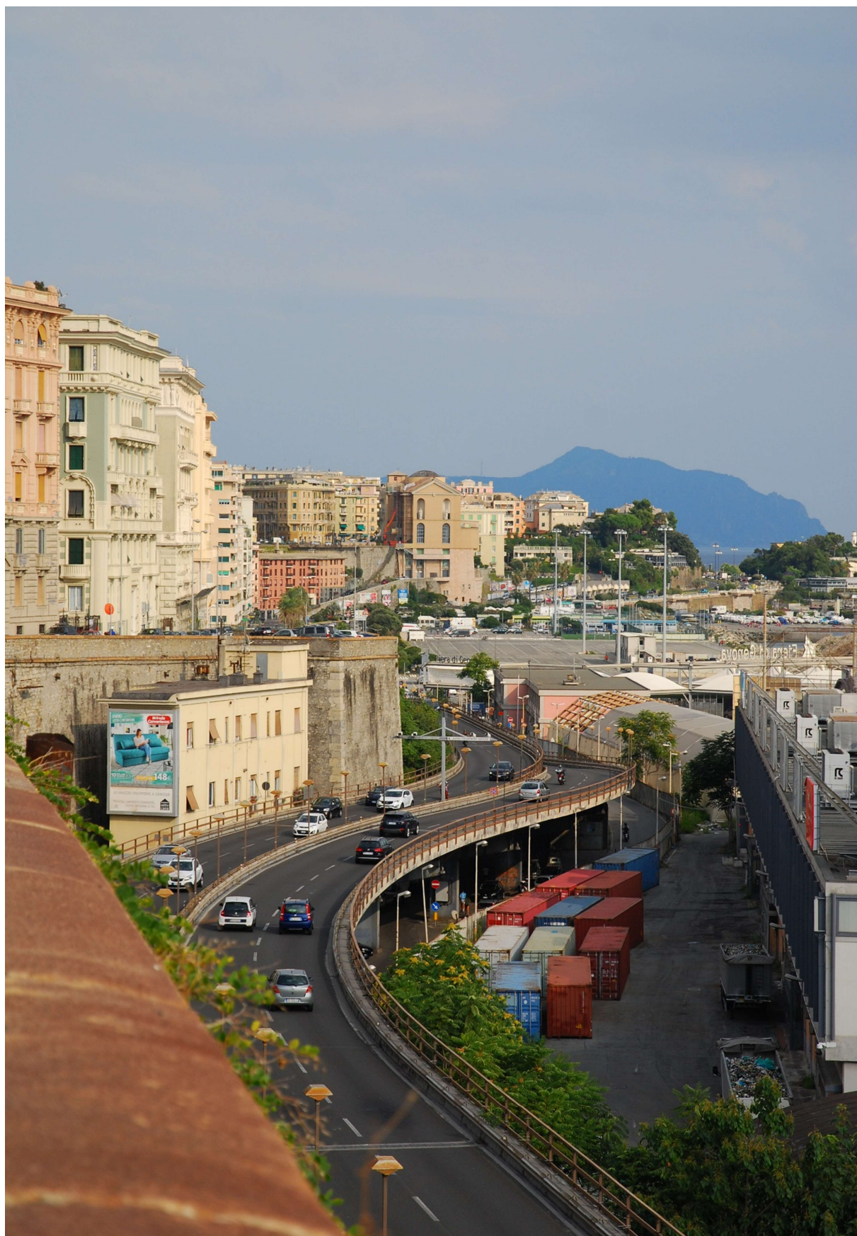
Vista Strada Statale 1, Sopraelevata Aldo Moro
