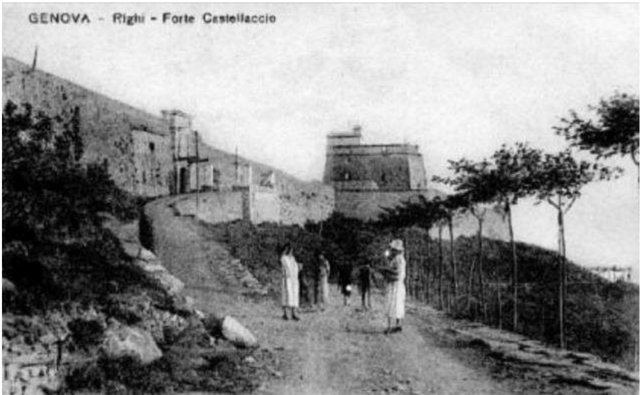
Foto d'epoca in cui si evidenzia la natura di strada bianca dell'originario percorso. Il colore scuro della foto d'epoca è dovuto alla qualità di riproduzione del documento fotografico.
