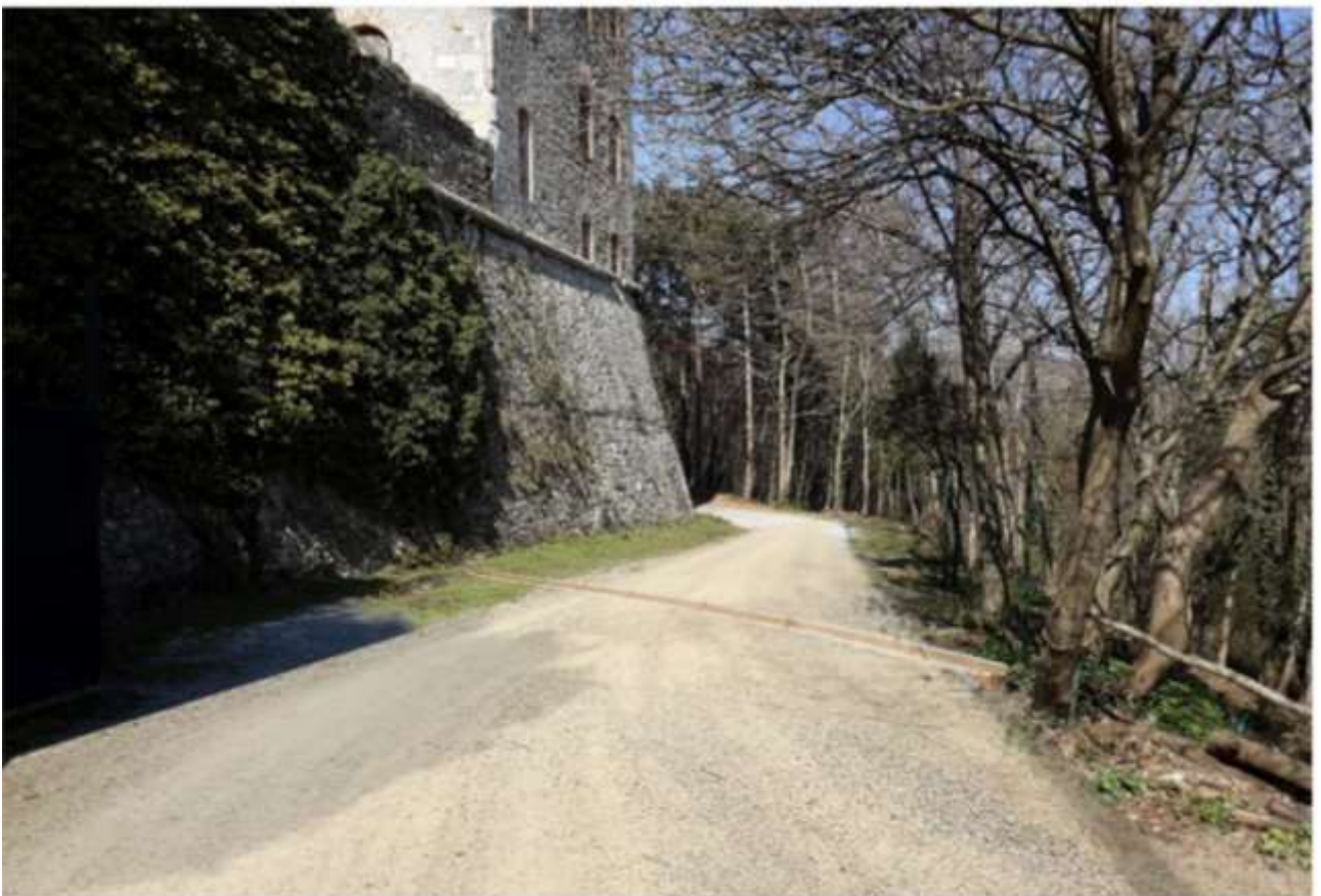
Rendering della messa in opera del percorso S1 nei pressi del Forte Castellaccio che riprende la conformazione originaria del percorso con l'aggiunta delle canalette di regimazione delle acque.
