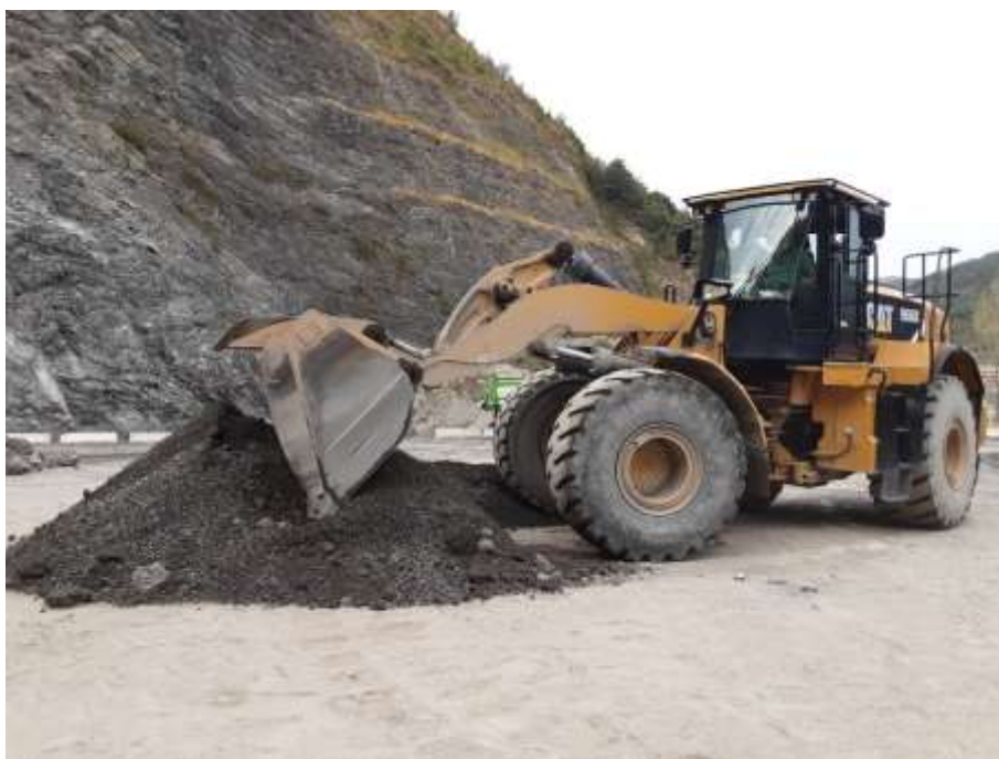
Figura 7: fase di preparazione della miscela di inerti in cava
