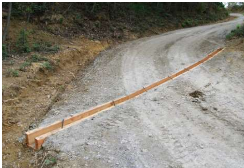
Figura 77: esempio di posizionamento di canaletta trasversale rispetto all'andamento del tracciato
