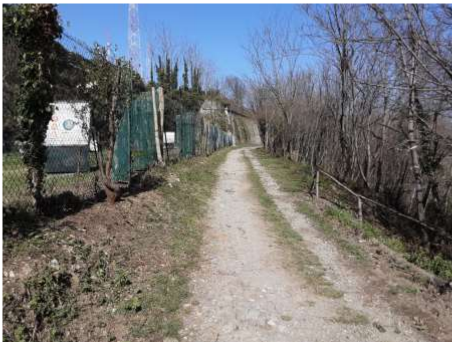
Figura 25: tratto iniziale del percorso S1 senza legante in corrispondenza del Forte Castellaccio
