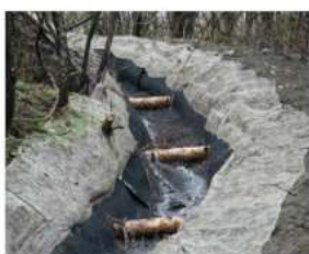
Figura 73: consigli di posa della canaletta trenchmat
