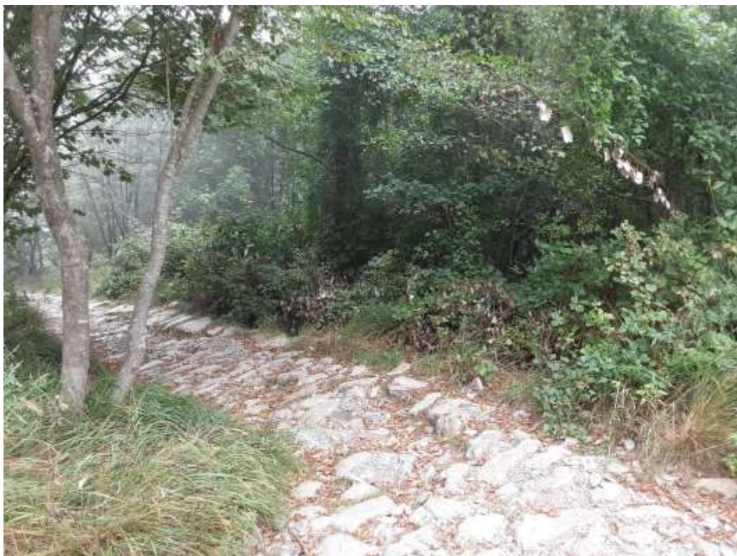
Figura 69: particolare della pavimentazione della strada militare per il forte
