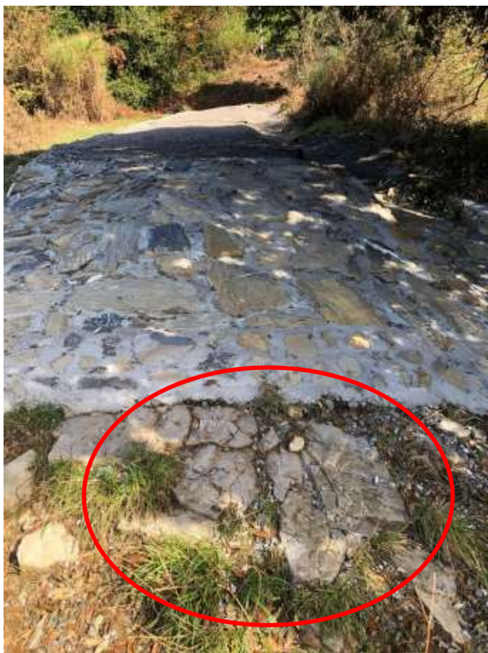
Figura 16: tratto di S1 realizzato in pietre cementate (campo prove Via Fea). L'effetto finale di questa tipologia di messa in opera sarà quello evidenziato nella parte bassa della foto
