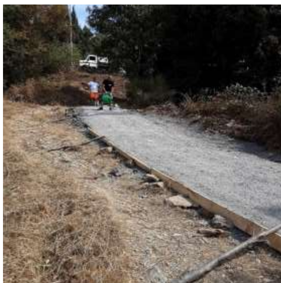
Figura 13: bagnatura finale con il prodotto SoilCement
