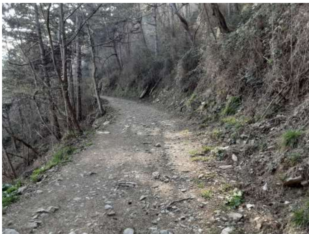
Figura 65: stato attuale del percorso lungo Via delle Baracche
