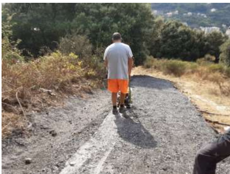
Figura 76: intasamento della canaletta con lo stesso materiale utilizzato per S1 (foto effettuate presso il campo prove allestito per il progetto)
