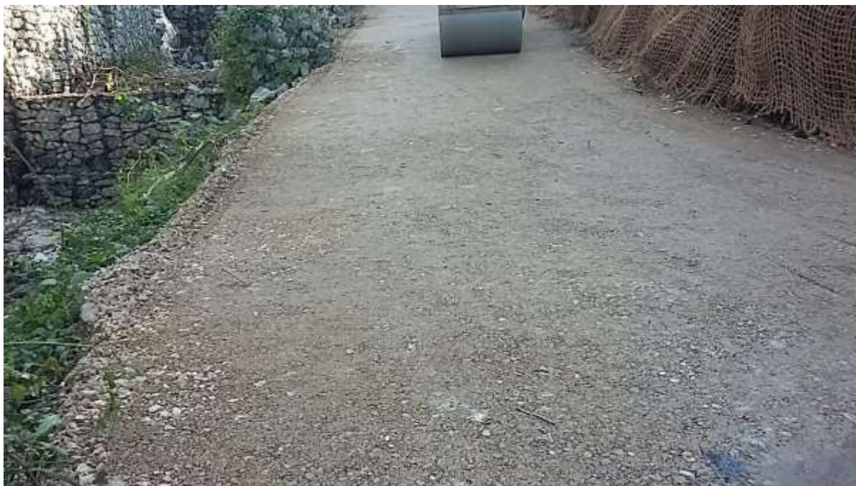
Figura 15: fasi di messa in opera del percorso S1 senza stabilizzanti
