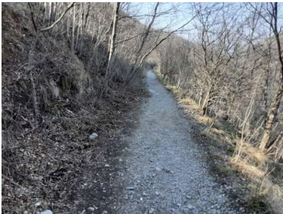
Figura 57: tratto di percorso attualmente in terra battuta che verrà regolarizzato ed ampliato leggermente senza utilizzo dei leganti.
