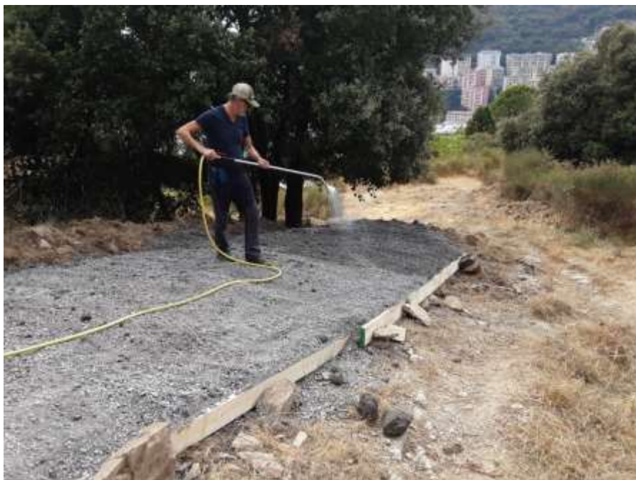
Figura 12: posa in opera della miscela di Green Stab e acqua sul percorso. In questo caso, trattandosi di un'area campione con problemi di accessibilità, la messa in opera è stata effettuata con l'uso di una pompa a mano.
