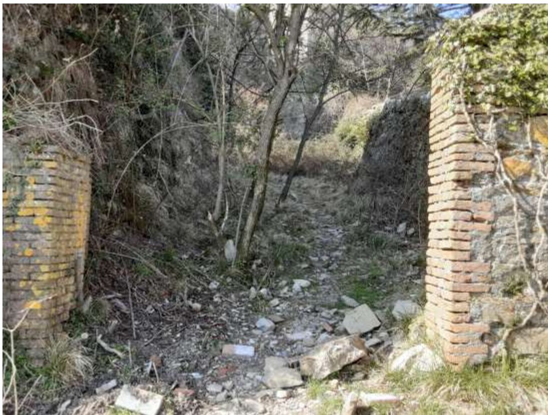
Figura 30: entrata nel perimetro interno del fossato del Forte Sperone a quota 485 m slm
