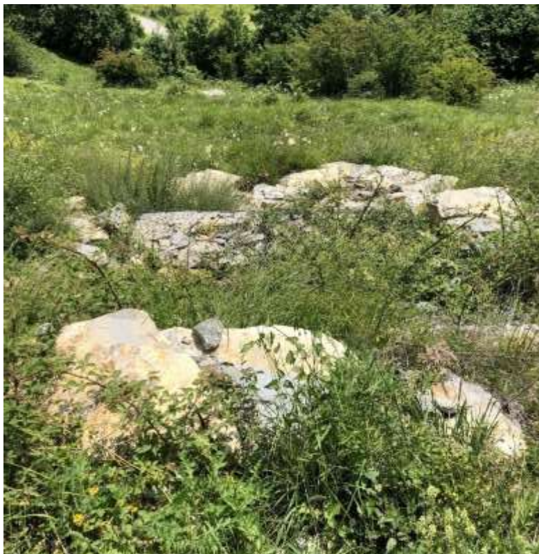
Figura 94: nel tempo la struttura viene quasi totalmente mascherata dalla vegetazione.
