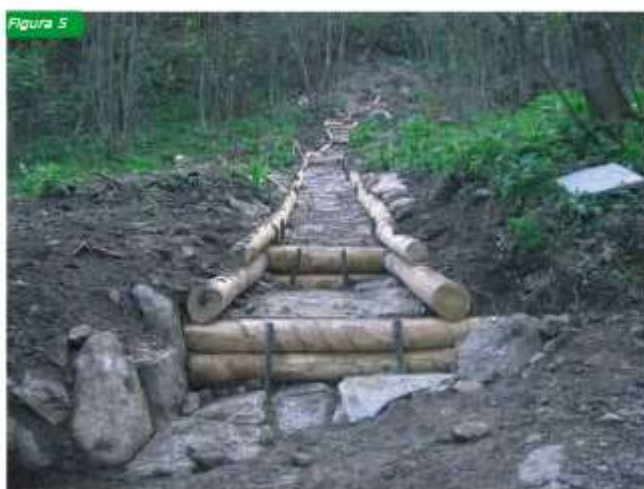
Figura 98: esempio di canaletta in legname e pietrame
