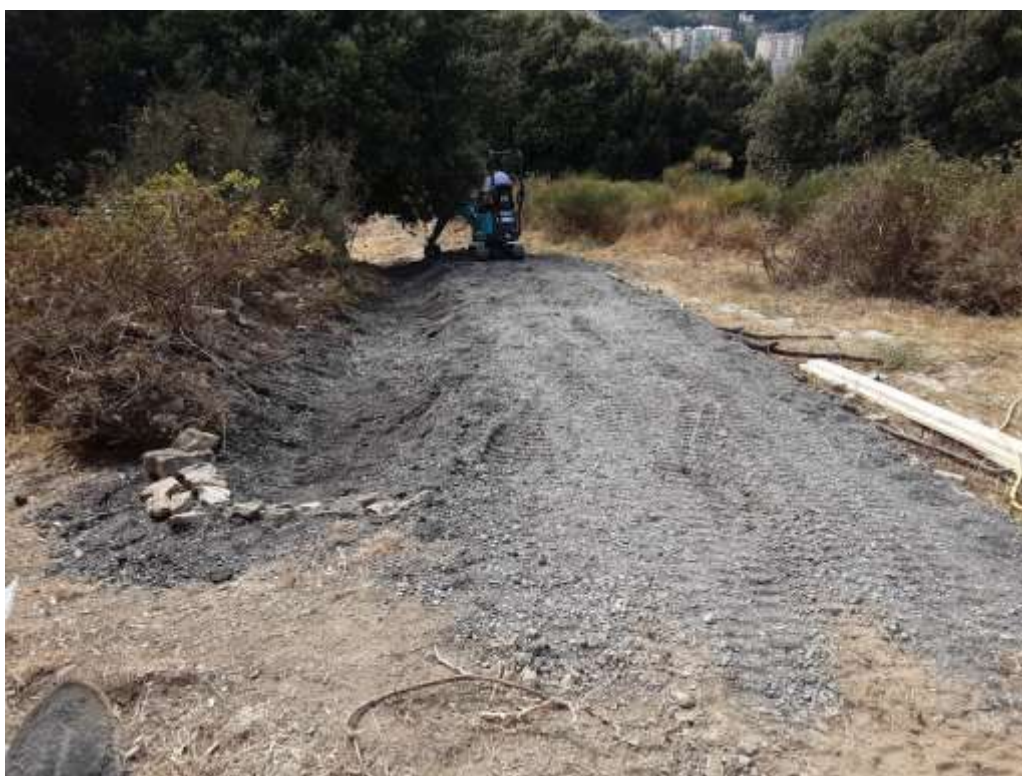
Figura 9: fasi di messa in opera della miscela di materiale inerte
