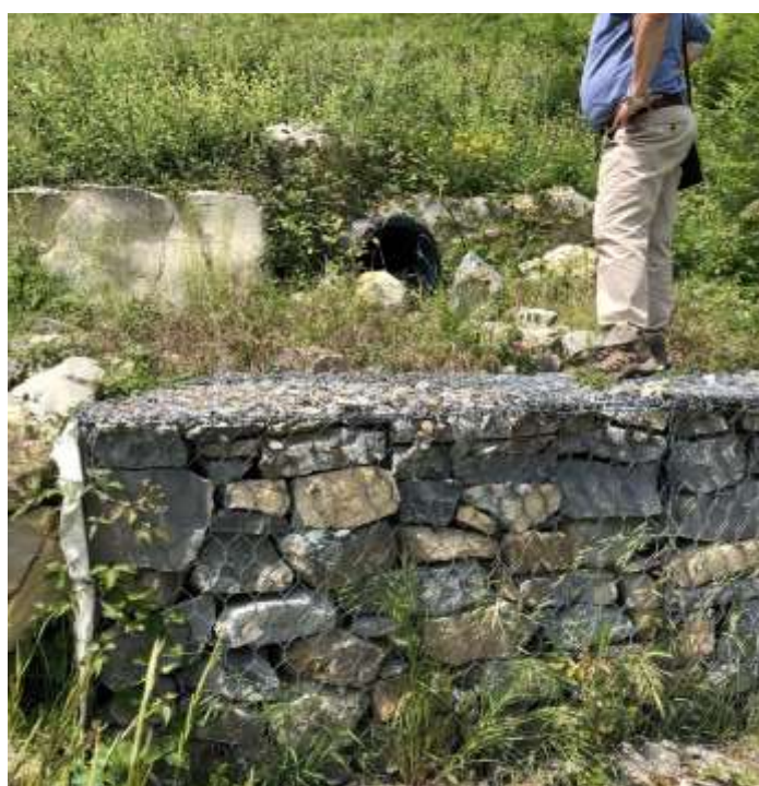
Figura 91 e seguente: esempio di vespaio drenante realizzato in altra area del contesto genovese. Si evidenzia la presenza del tubo che convoglia le acque di versante verso i gabbioni in pietra
