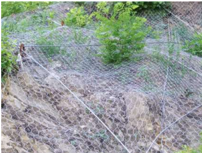
Figura 104: esempio di applicazione di rete metallica a doppia torsione
