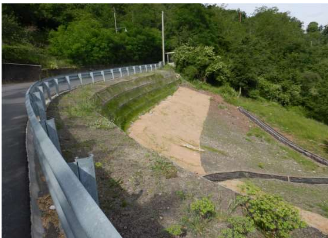
Figura 61: esempio di intervento con terre rinforzate eseguito dal Settore Geotecnica e Idrogeologia, Espropri e Vallate del Comune di Genova
