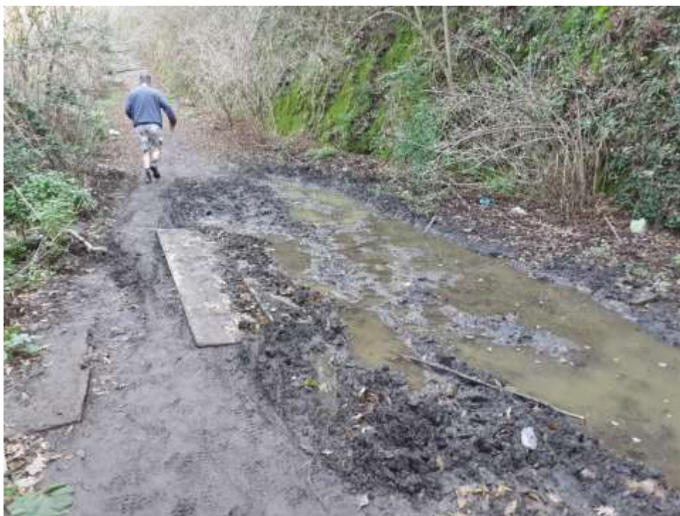
Figura 33: ristagno d'acqua permanente a causa dell'altimetria del percorso attuale e della mancanza di regimazione delle acque superficiali.
