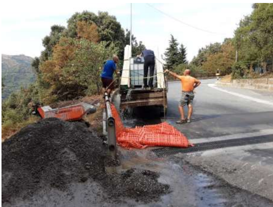
Figura 11: miscelazione del prodotto Green Stab con l'acqua
