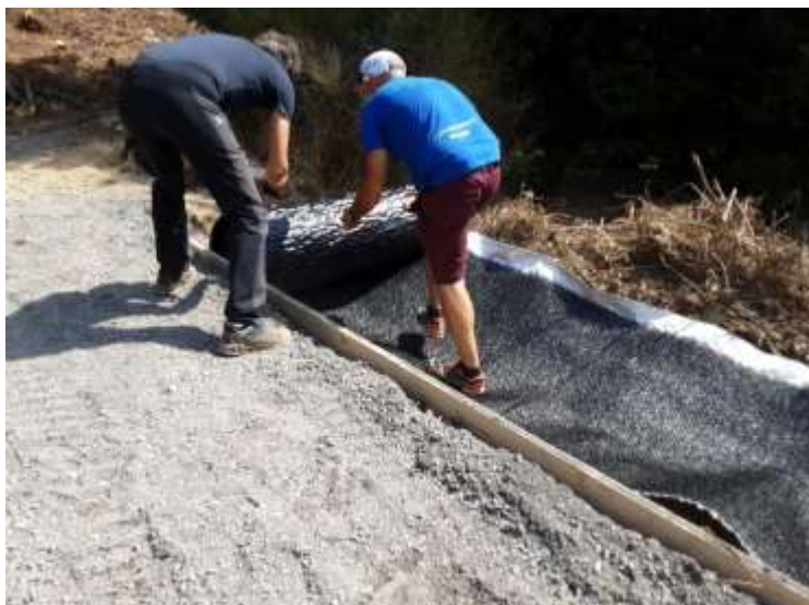
Figura 75: stesa della canaletta tipo trenchmat parallelamente al tracciato
