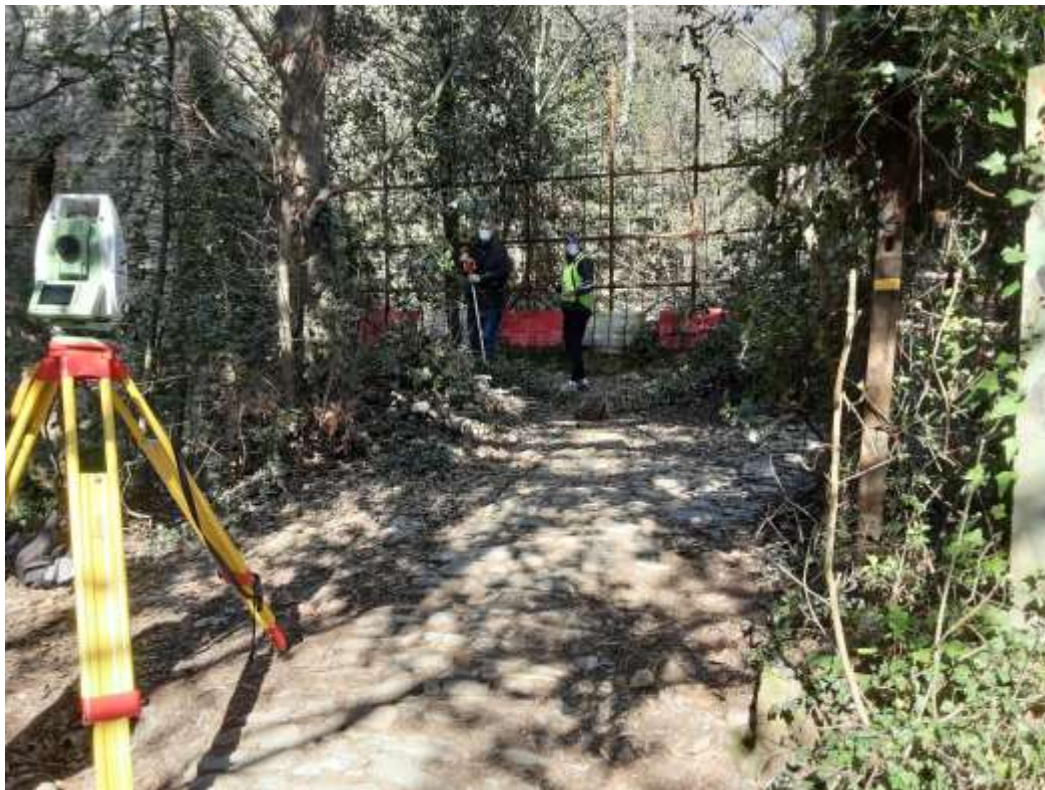
Figura 85: il percorso si interrompe in questo punto. Per continuare occorre deviare a destra e by passare il tratto franato.
