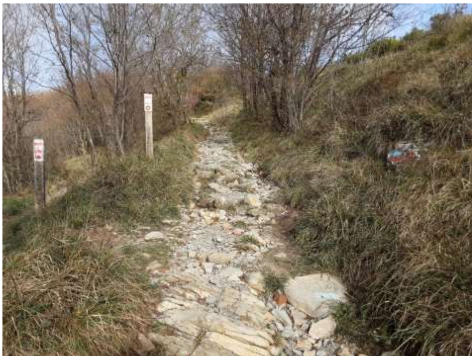
Figura 47: tratto in corrispondenza del bivio con il sentiero per Bolzaneto, con presenza di roccia affiorante in cui S1 verrà realizzato in pietre e cemento
