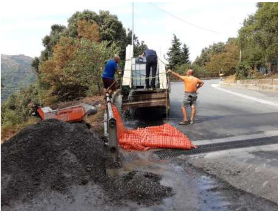
Figura 5: miscelazione del prodotto Green Stab con l'acqua
