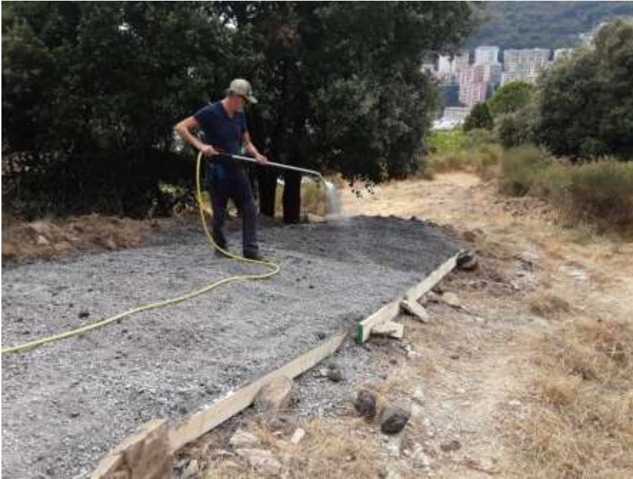
Figura 6: posa in opera della miscela di Green Stab e acqua sul percorso. In questo caso, trattandosi di un'area campione con problemi di accessibilità, la messa in opera è stata effettuata con l'uso di una pompa a mano.
