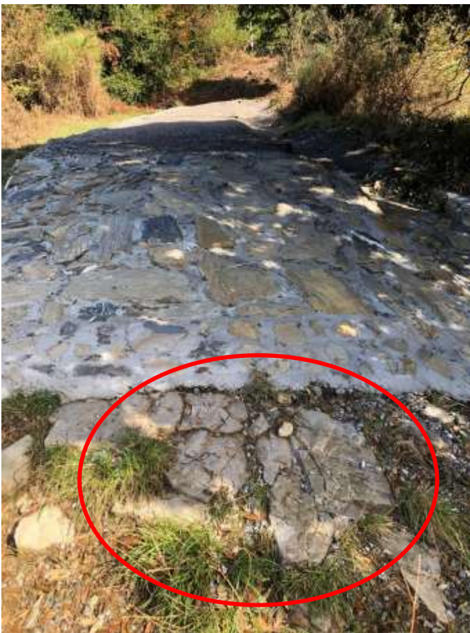
Figura 12: tratto di S1 realizzato in pietre cementate (campo prove Via Fea). L'effetto finale di questa tipologia di messa in opera sarà quello evidenziato nella parte bassa della foto
