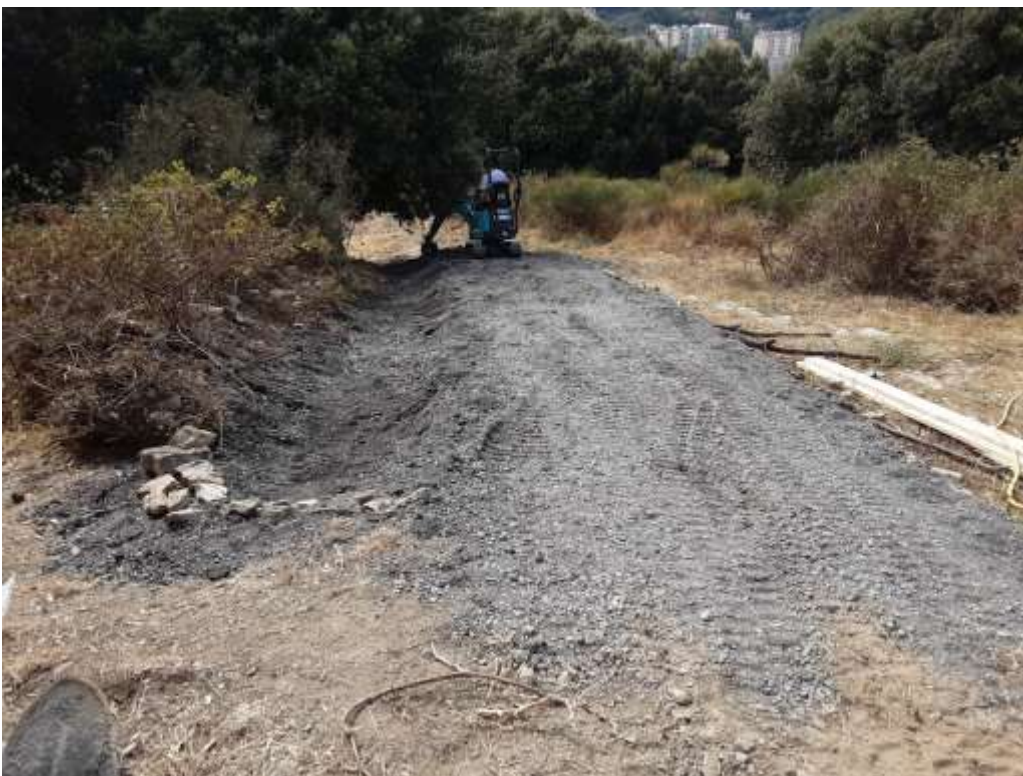
Figura 3: fasi di messa in opera della miscela di materiale inerte
