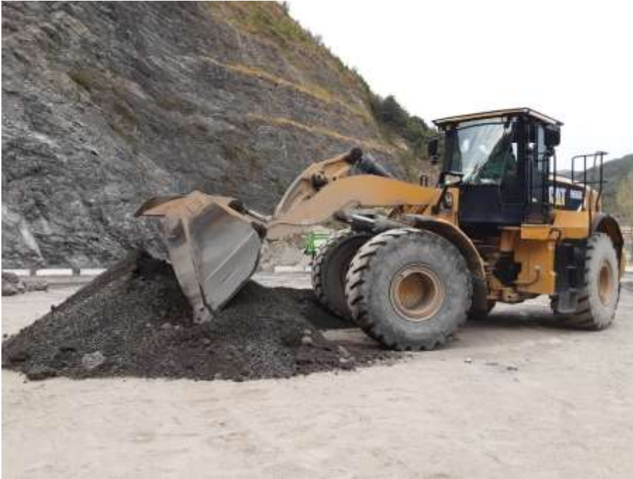
Figura 1: fase di preparazione della miscela di inerti in cava
