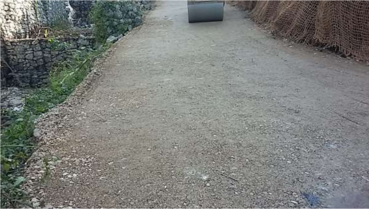
Figura 9, 10, 11: fasi di messa in opera del percorso S1 senza stabilizzanti naturali
