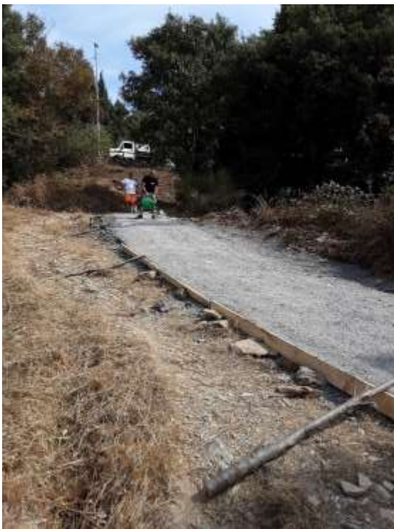
Figura 7: bagnatura finale con il prodotto SoilCement
