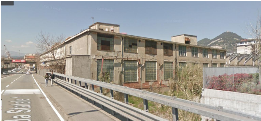
-VISTA DA VIA ALBARETO - IL MURO DI CONFINE VERSO LEVANTE COSTITUISCE ARGINE DEL T.CHIARAVAGNA
