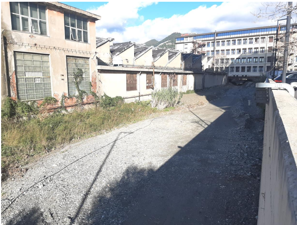
- VISTA ALVEO T. CHIARAVAGNA – TRATTO MEDIANO – MURO D'ARGINE ESISTENTE
