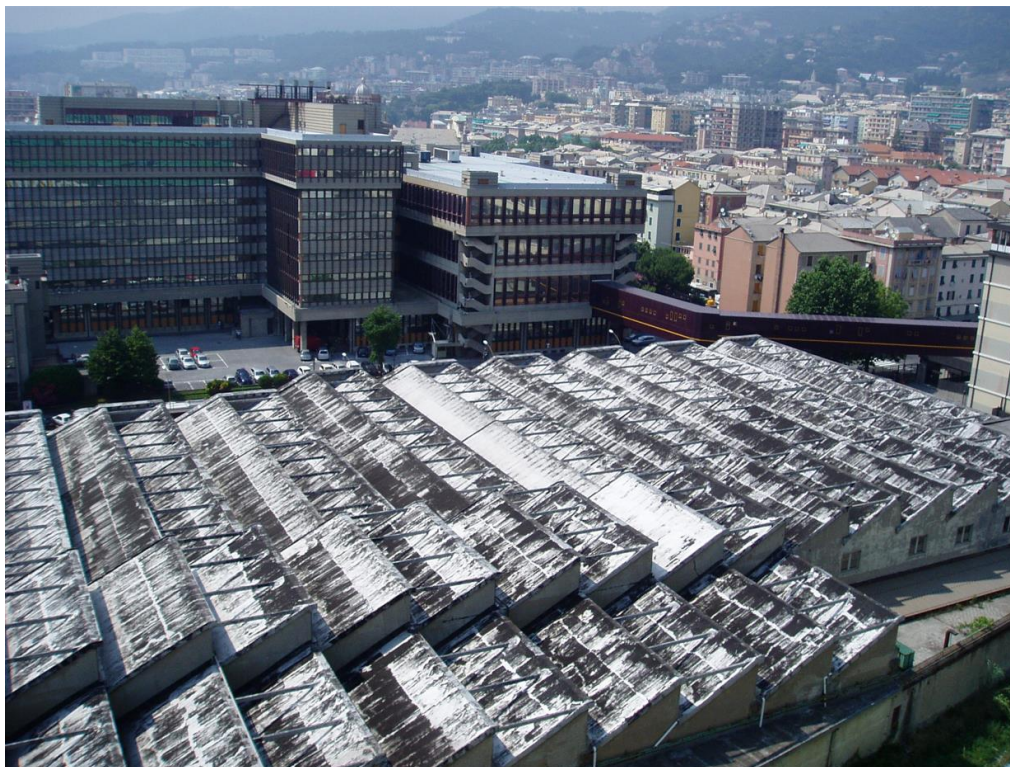
- VISTA AEREA – DETTAGLIO COPERTURE TRATTO INTERMEDIO -
