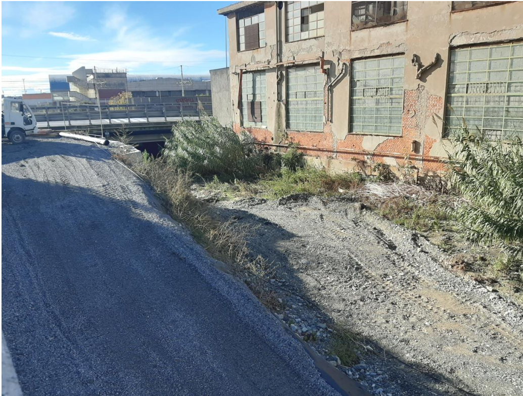
- VISTA ALVEO T. CHIARAVAGNA – VERSO MARE – MURO D'ARGINE ESISTENTE
