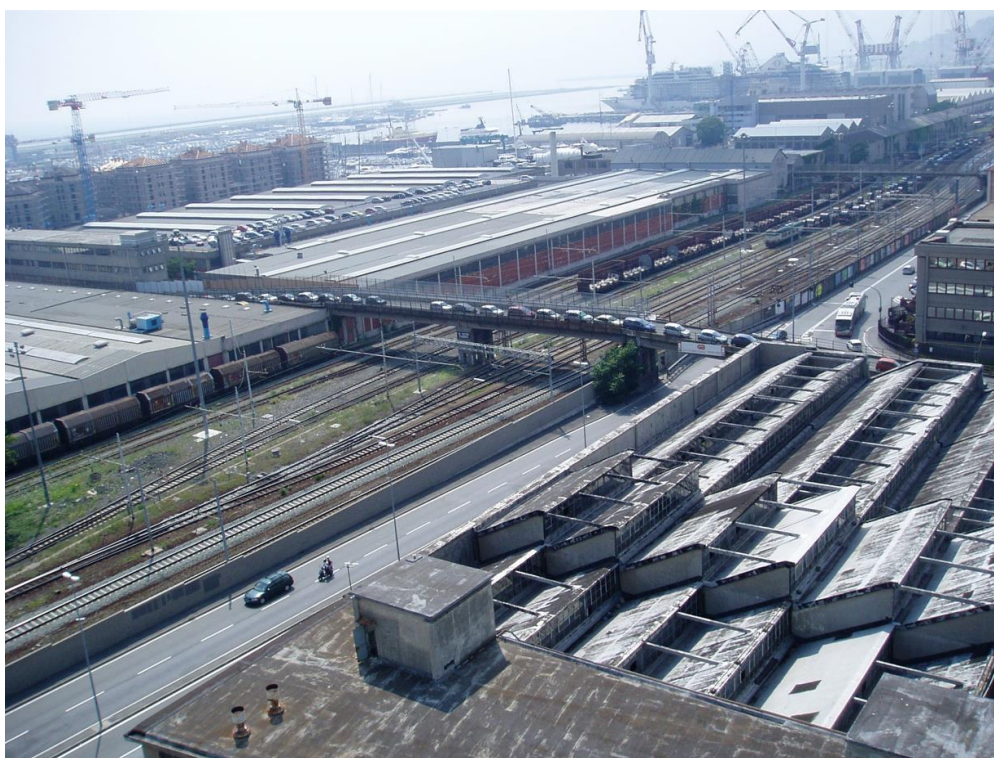
- VISTA AEREA – DETTAGLIO COPERTURE LATO MARE -
