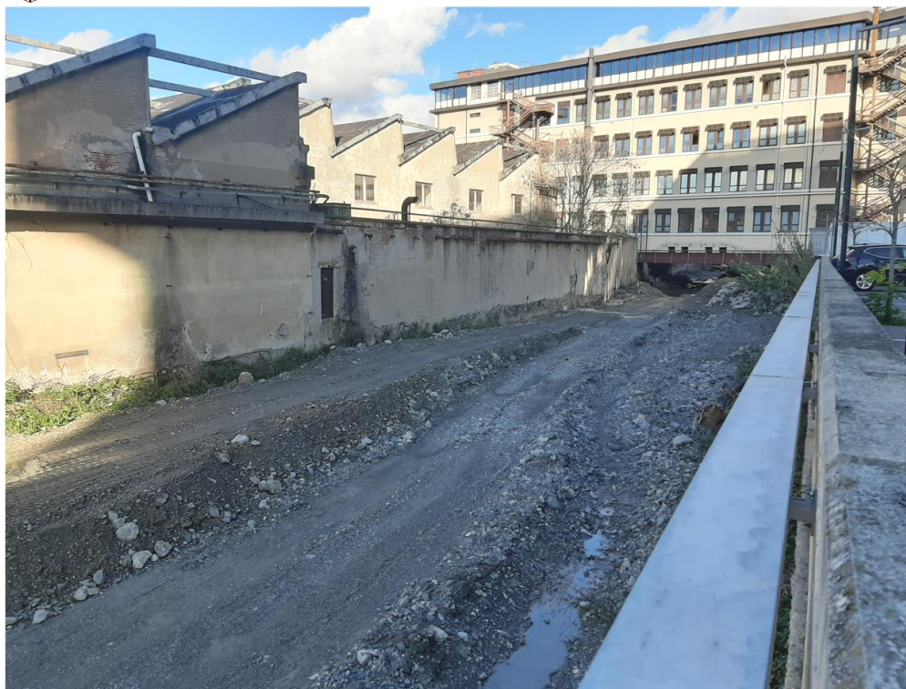
- VISTA ALVEO T. CHIARAVAGNA – VERSO MONTE – MURO D'ARGINE ESISTENTE
