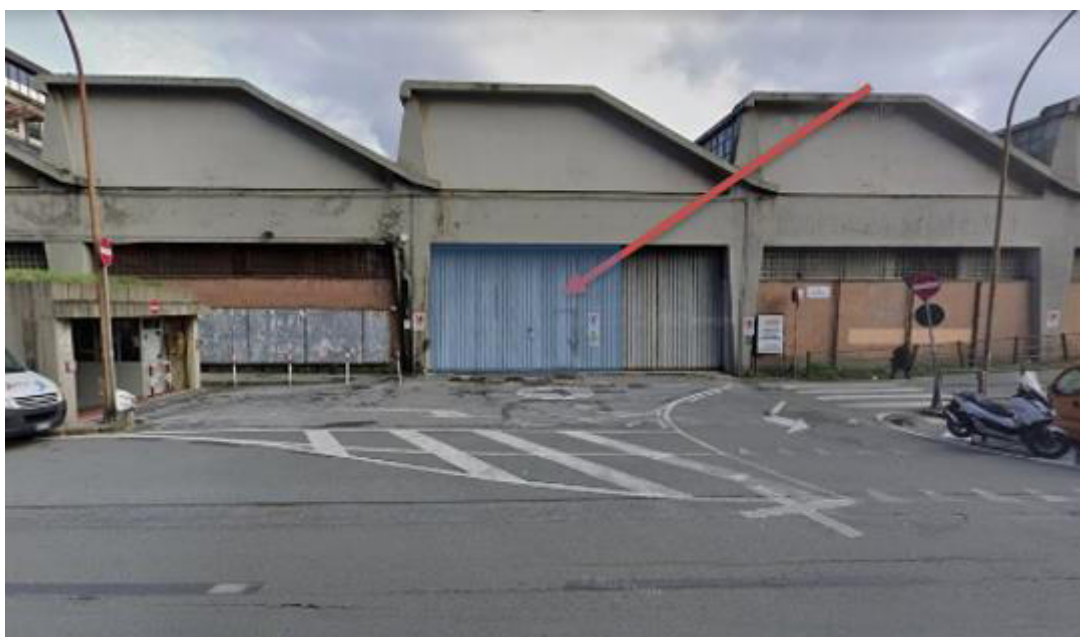
Figura 97: varco di uscita delle merci su via Hermada
