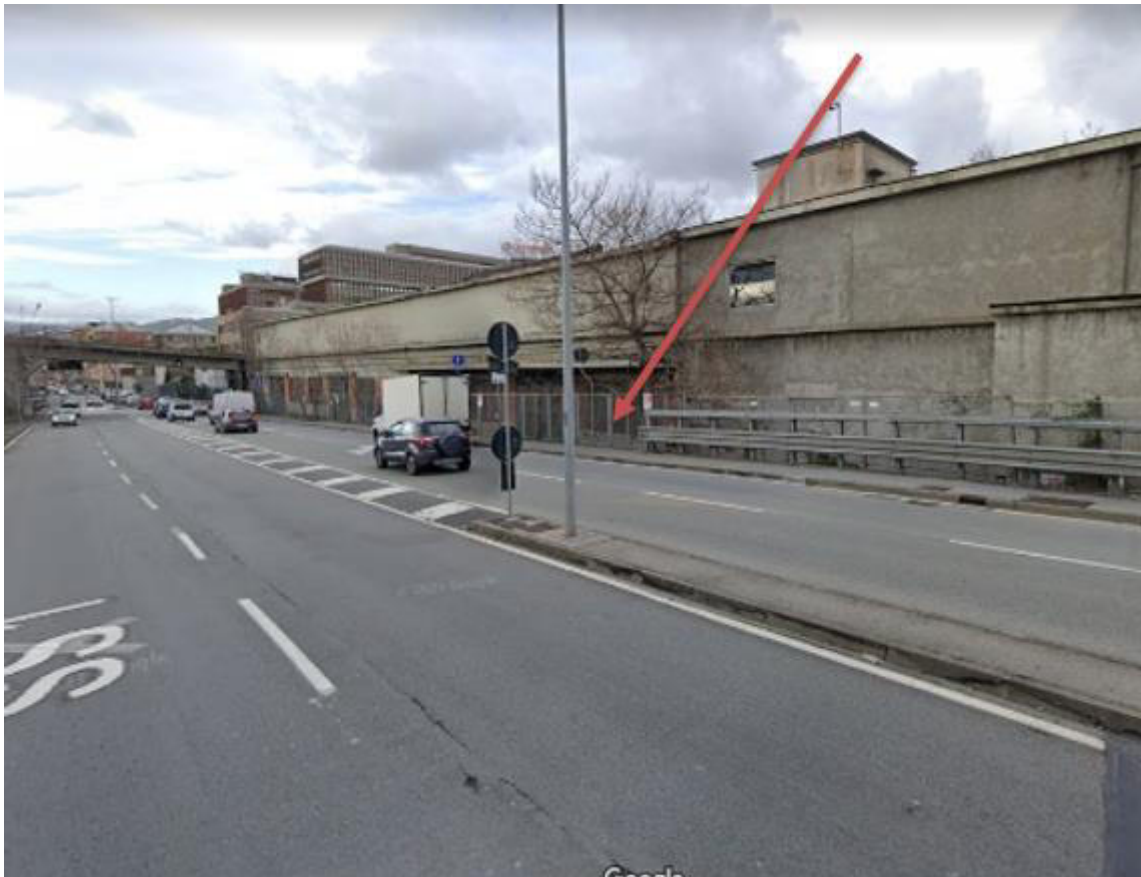
Figura 90: punto di innesto su via Albareto del nuovo tronco stradale
