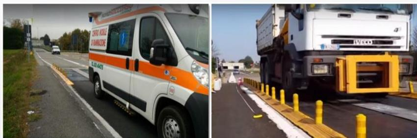
Il dimensionamento dell'impianto di recupero di energia cinetica delle automobili è stato effettuato utilizzando i dati del modello di traffico e si ottiene una produzione annua superiore a 25.000 kWh.
