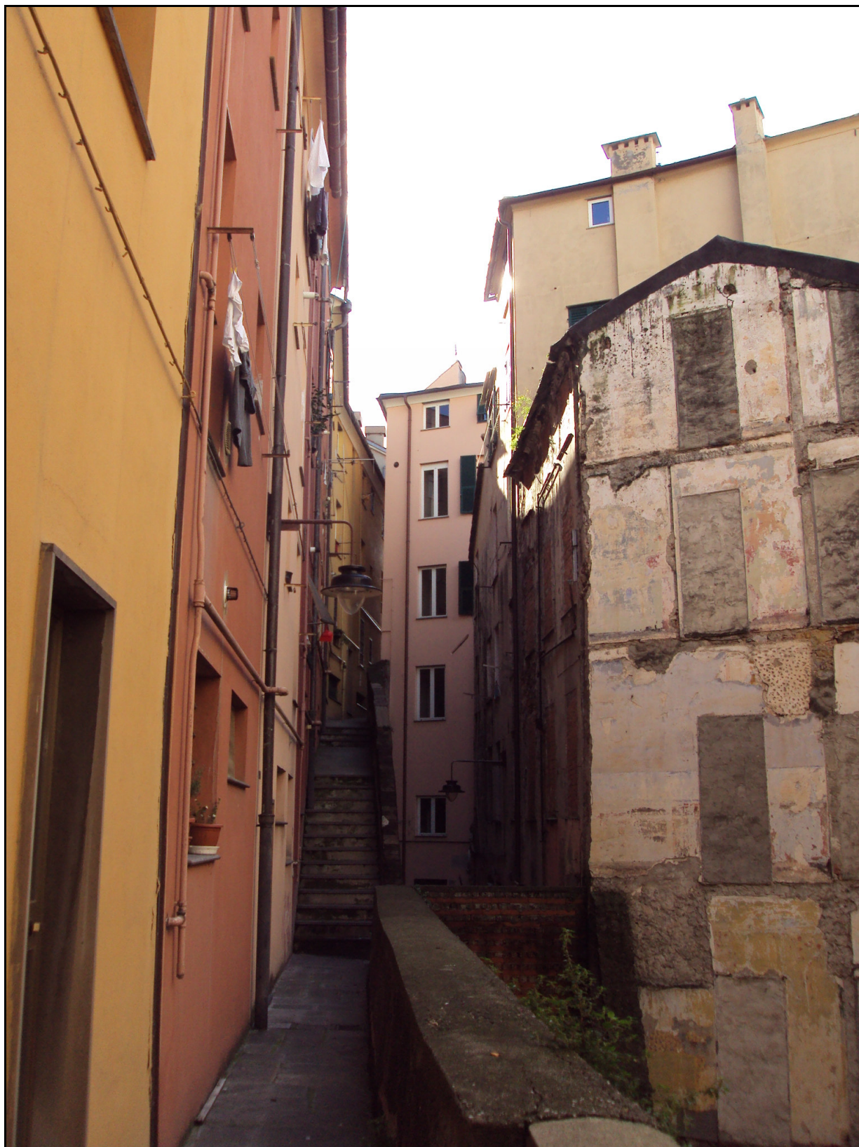
4. Vista dell'edificio di Vico Coccagna 3 dalla soprastante Via delle Murette
