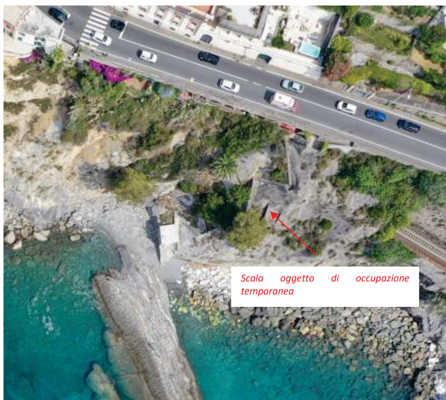
Foto 8.1: foto del mappale 878 con indicazione della scala oggetto di temporanea occupazione
