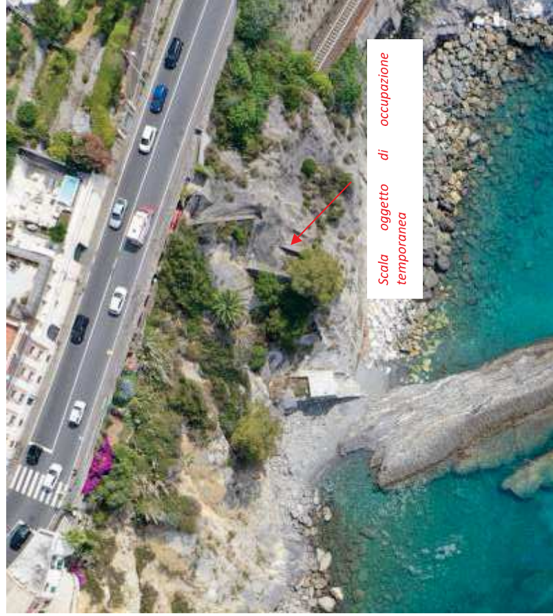
Foto 8.1: foto del mappale 878 con indicazione della scala oggetto di temporanea occupazione
