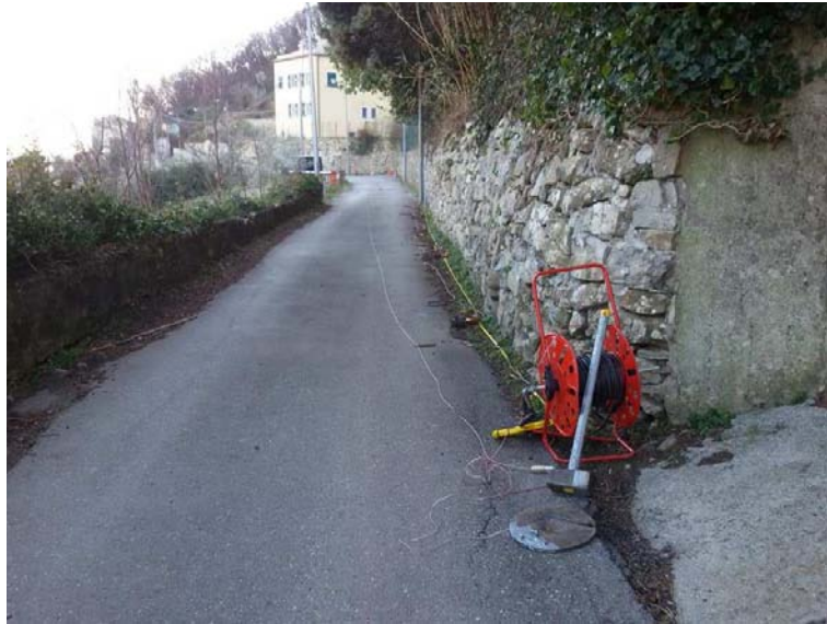
Stendimento sismico tomografico SS3, estremo finale (piastra in offset lato geofono G20)
