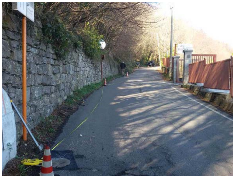
Stendimento sismico tomografico SS1, estremo iniziale (mazza e piastra in offset lato geofono G1)
