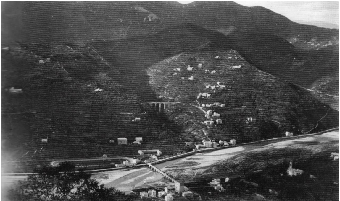
Figura 6. Veduta dell'area di Gavette e del Ponte Carrega dalla Torre Quezzi (1902) In primo piano il Ponte Carrega.
