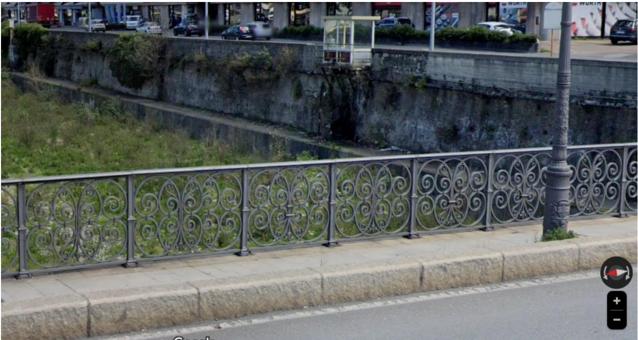
Fangodotto staffato all'argine in sponda sinistra presso Ponte Monteverde ( Staglieno )
