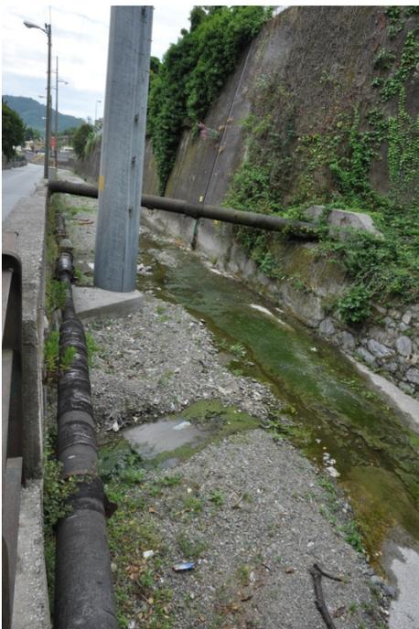
Fig. 17 – Accumuli di detriti sul letto in cemento
