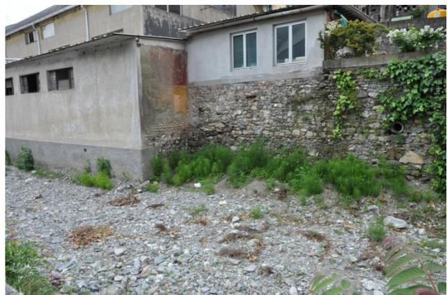
Fig. 10 – Edificio impostato sull'argine SE in pietre
