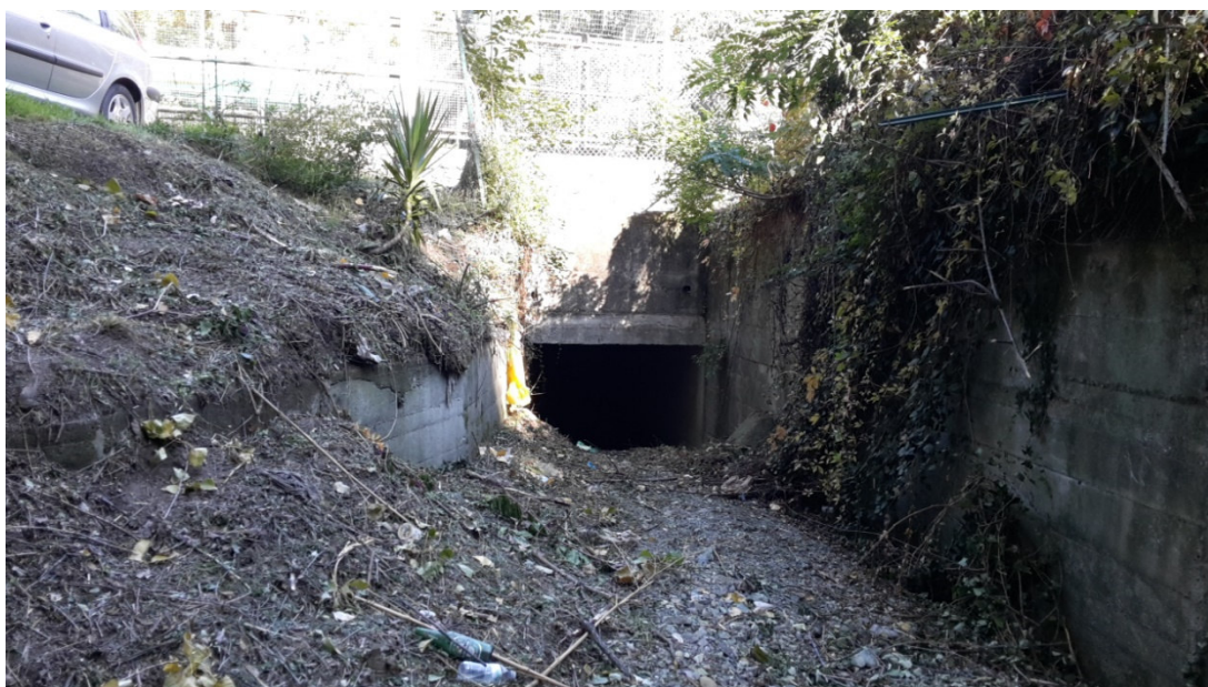
Foto 4 – Foto che inquadra, verso valle, la sezione di imbocco del tratto tombinato esistente (sez. 57); foto scattata dopo la pulizia dell'alveo eseguita recentemente dal Comune di Genova.
