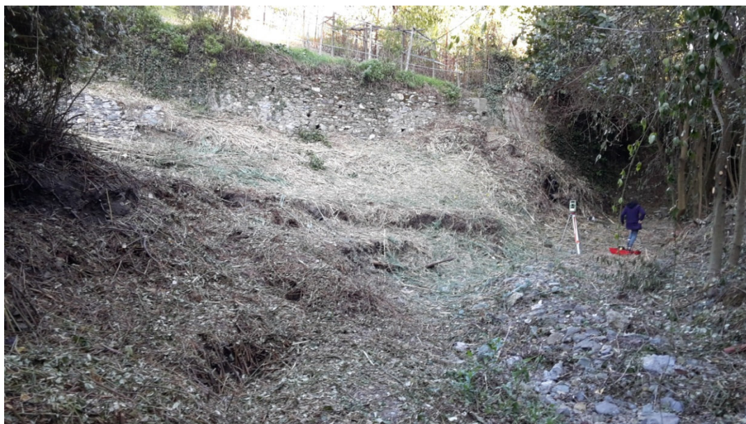
Foto 1 – Foto scattata in corrispondenza della sezione 65 (sezione di controllo) verso valle.
