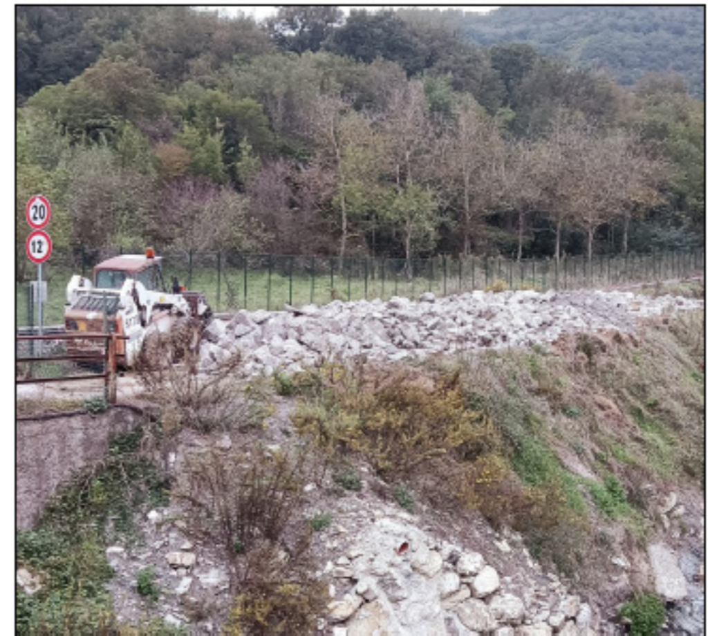
Rio Bastia: Sgombero del materiale lapideo grossolano e stoccaggio temporaneo per riutilizzo in altri cantieri
