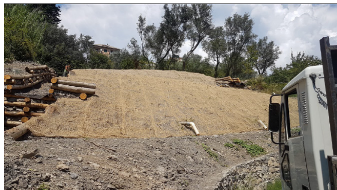
Sistemazione antiersiva delle scarpate con rete di cocco.
