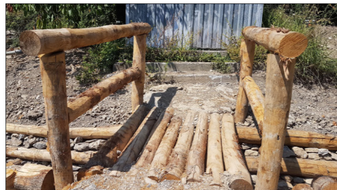
Realizzazione di piccoli attraversamenti sul canale.
