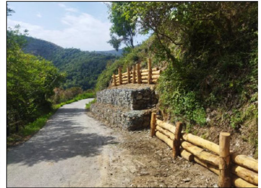
Via San Pietro ai prati e Salita Tuvio retatura parete rocciosa, opere di sostegno in gabbioni di pietrame, palizzate semplici regimazione acque
