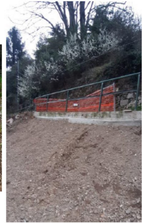
Salita Castrofino, in corso d'opera
