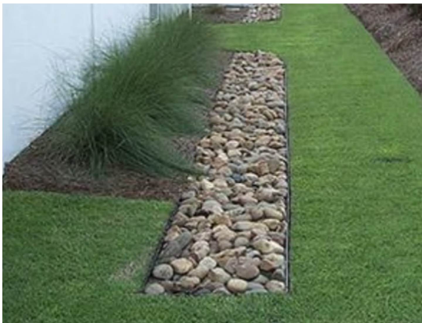
Esempio di trincea
