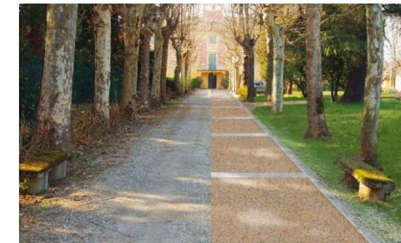
Pavimentazione permeabile senza infiltrazione nel sottosuolo con raccolta delle acque ed invio alla fognatura e/o accoppiamento con altri sistemi di infiltrazione
