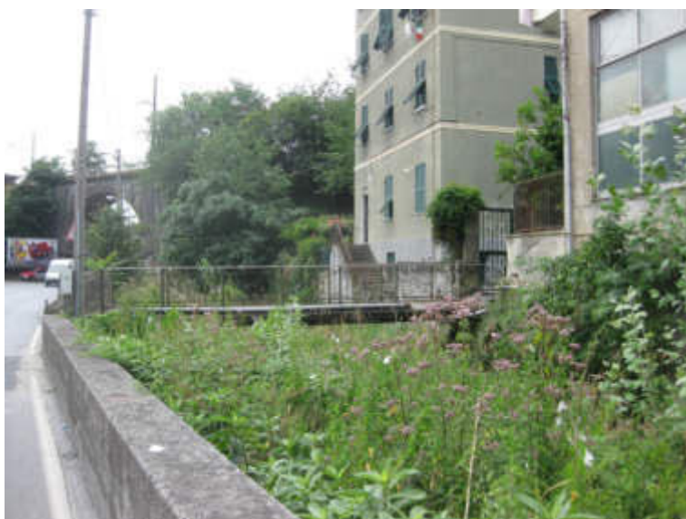
Foto 8 – Foto scattata in corrispondenza della sezione 13 verso valle; si osserva la passerella pubblica in ferro presente in corrispondenza della sezione 12.
