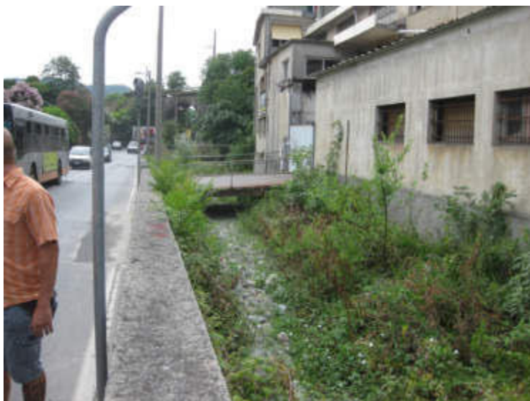
Foto 9 – Foto scattata in corrispondenza della sezione 14 verso valle; si osserva il ponte carrabile in ferro in corrispondenza della sezione 13.
