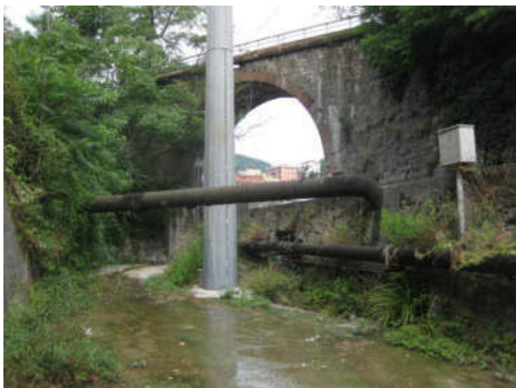
Foto 5 – Foto scattata in corrispondenza della sezione 7 verso monte; si osserva il palo della linea ferroviaria in alveo, la tubazione \phi 400 dell'acquedotto che attraversa il rio, la tubazione del gas \phi 250 staffata sul muro d'argine in sponda sinistra e il ponte ferroviario ad arco.
