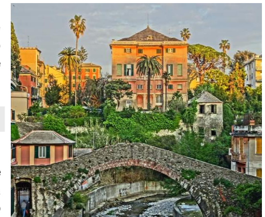
Il Ponte Romano di Nervi e Villa Gnecco
