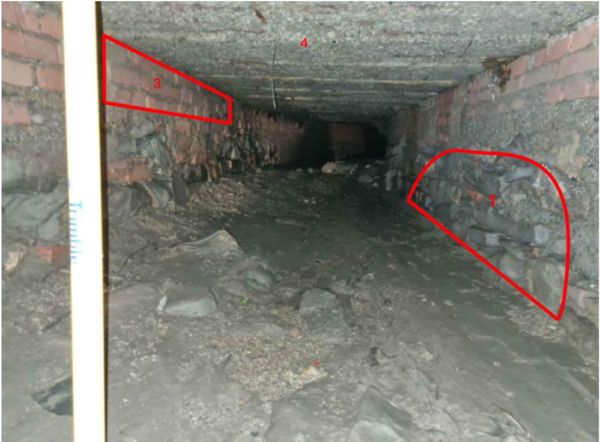
Fig. 4 – Altre murature: muratura di età moderna (1); muratura recente (3); soletta in c. a. recente (4).
