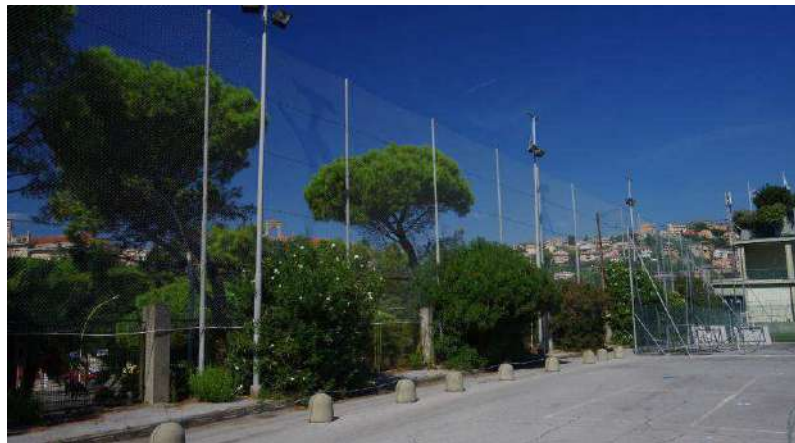
Foto n. 1: l'angolo nord ovest dell'area, vista generale
