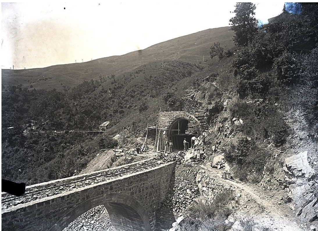
Galleria Fontanazza e ponte sul Rio Pelagallo
