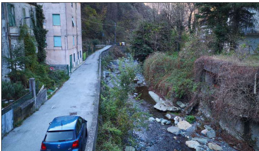
FOTO N.4 - secondo tratto, visto da monte, dalla spalla sinistra della passerella pedonale, ove il nuovo muro in sinistra si svilupperà in corrispondenza del muretto esistente. Si nota la griglia stradale di aerazione e controllo della confluenza nel Varena del rio senza nome già evidenziato al punto 1.3.
