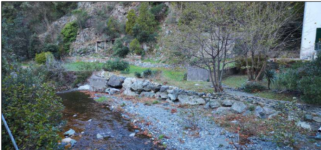
FOTO N.7 - tratto terminale dell'intervento in sponda destra, ove si intravede la briglia esistente, sulla quale termina il nuovo muro d'argine; la prevista difesa spondale continua con colmata dell'area verde visibile nella foto, previo scotico e ripresa del verde sulla colmata realizzata con terreno proveniente dagli scavi. Tale area è soggetta ad esondazione da piene di ricorrenza anche cinquantennale (area "rossa").
