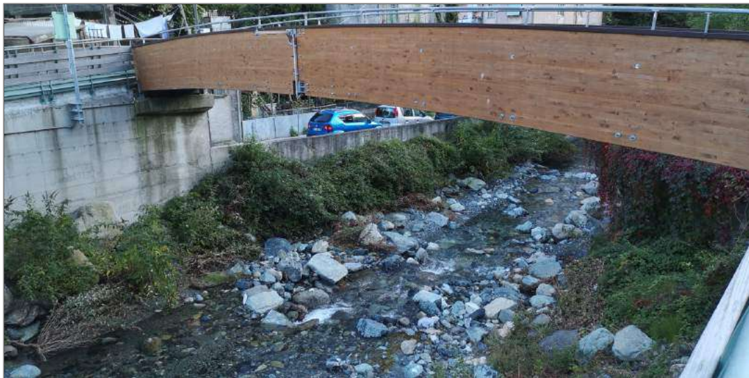
FOTO N.1 - passerella pedonale realizzata nell'ambito del 1° lotto; dalle sue spalle sono state scattate le foto 2,3,4,5,
