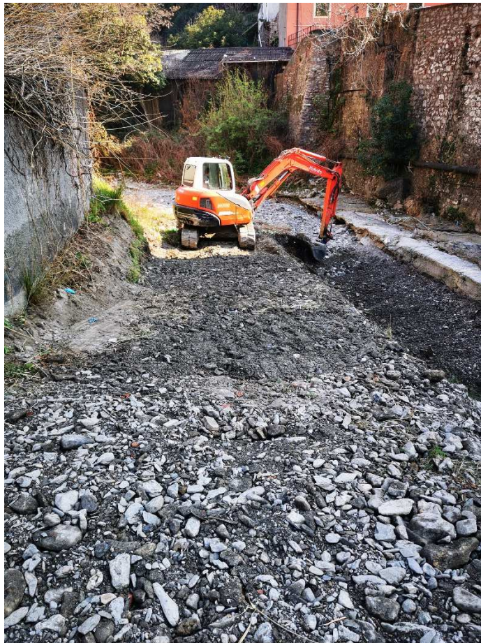
Figura 9-1– Scavo di pozzetto esplorativo con escavatore Kubota KX080-3
