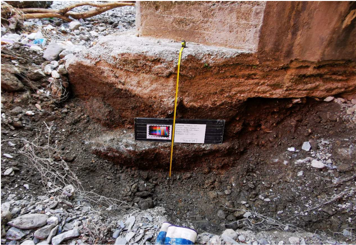
Pozzetto PE 05 foto 1
