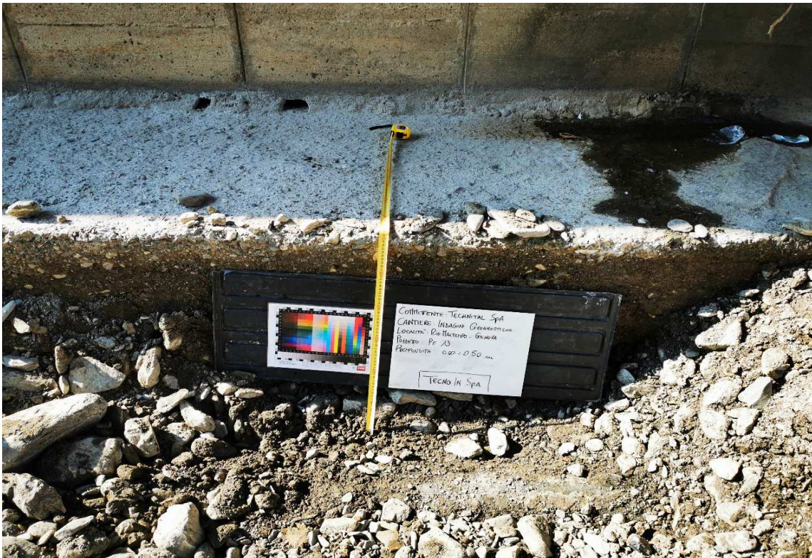
Pozzetto PE 13 foto 1
