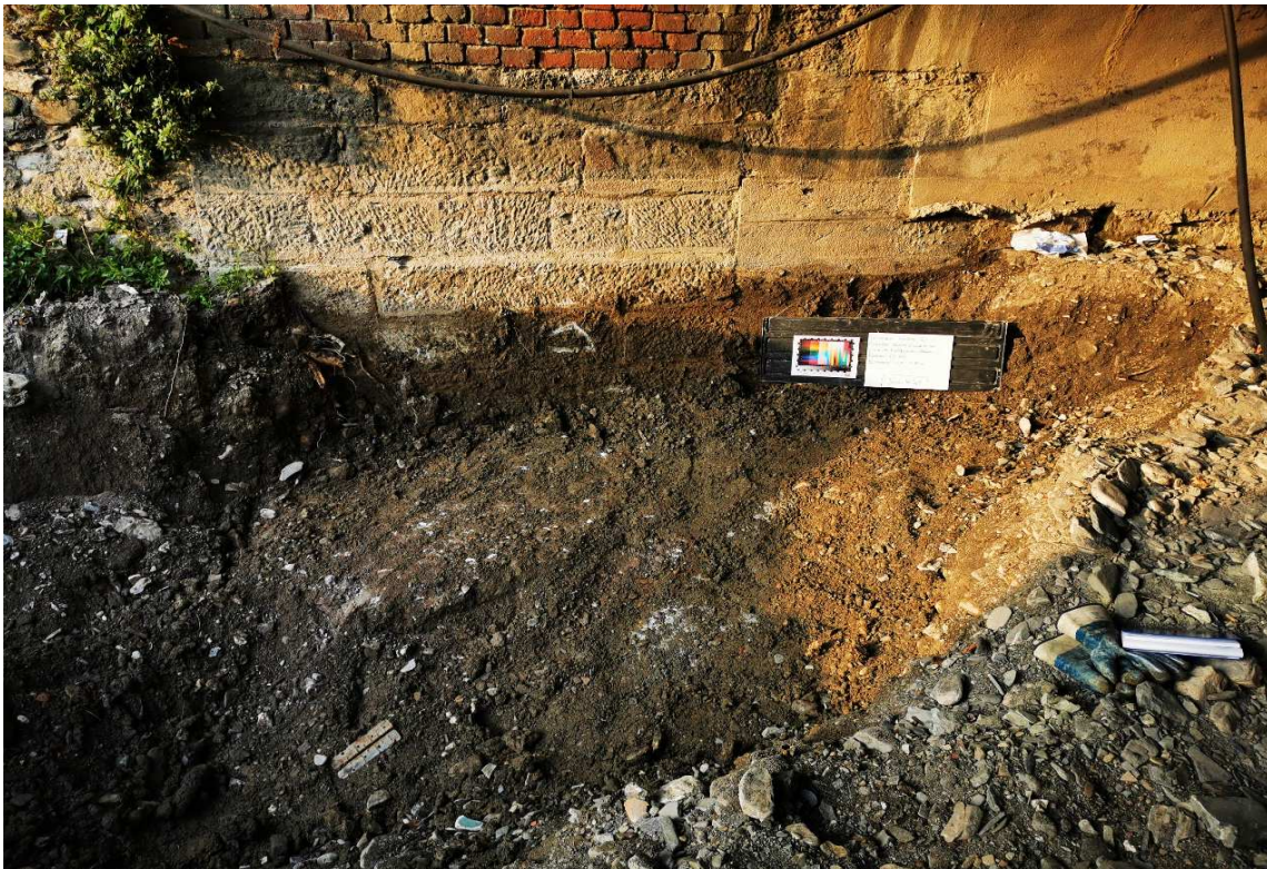
Pozzetto PE 06 foto 1
