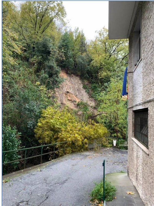
Figura 10.8 Dissesto in sinistra Rio Maltempo a valle dell'opera di presa
