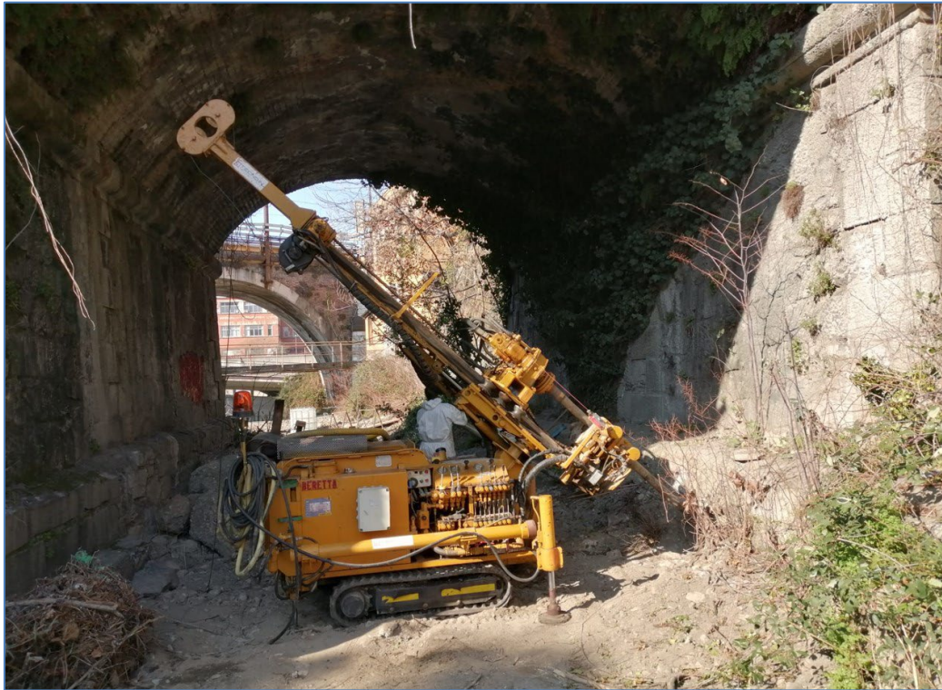
Foto 10.2 Esecuzione del carotaggio CA01 sul ponte FFSS
