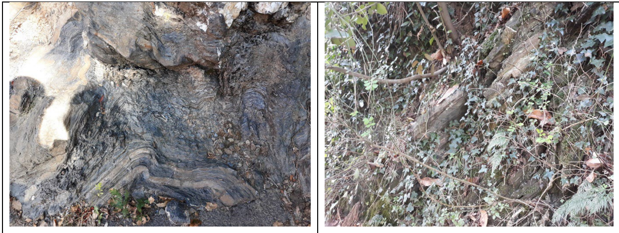
Figura 10.5 A sinistra argilliti con struttura fissile e noduli di quarzo affioranti in asse galleria. A destra argilliti lungo la sponda destra del Rio Maltempo in zona opera di presa
