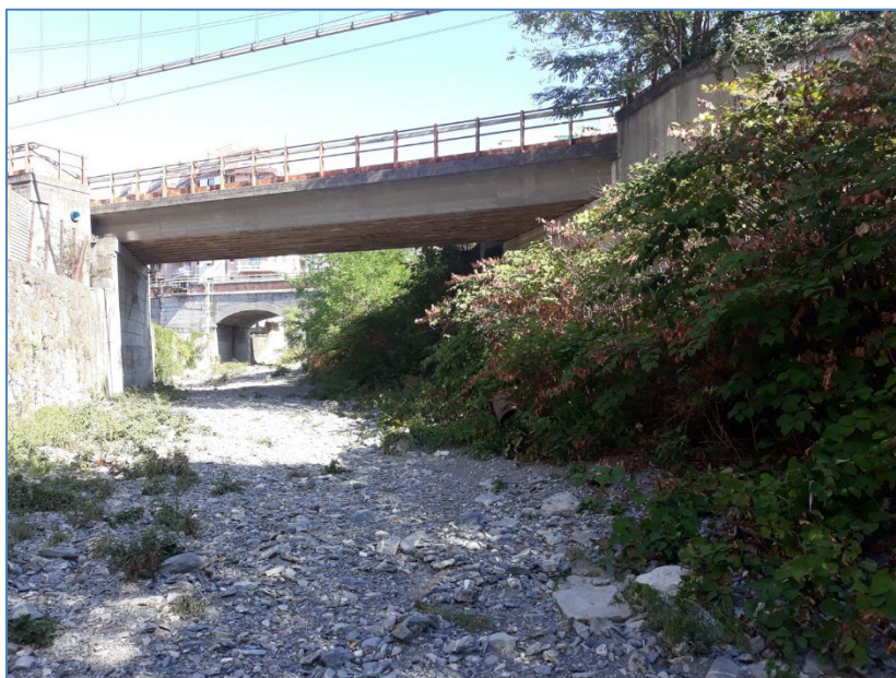
Figura 10.6 Alveo del Torrente Torbella a valle dello sbocco della galleria idraulica
