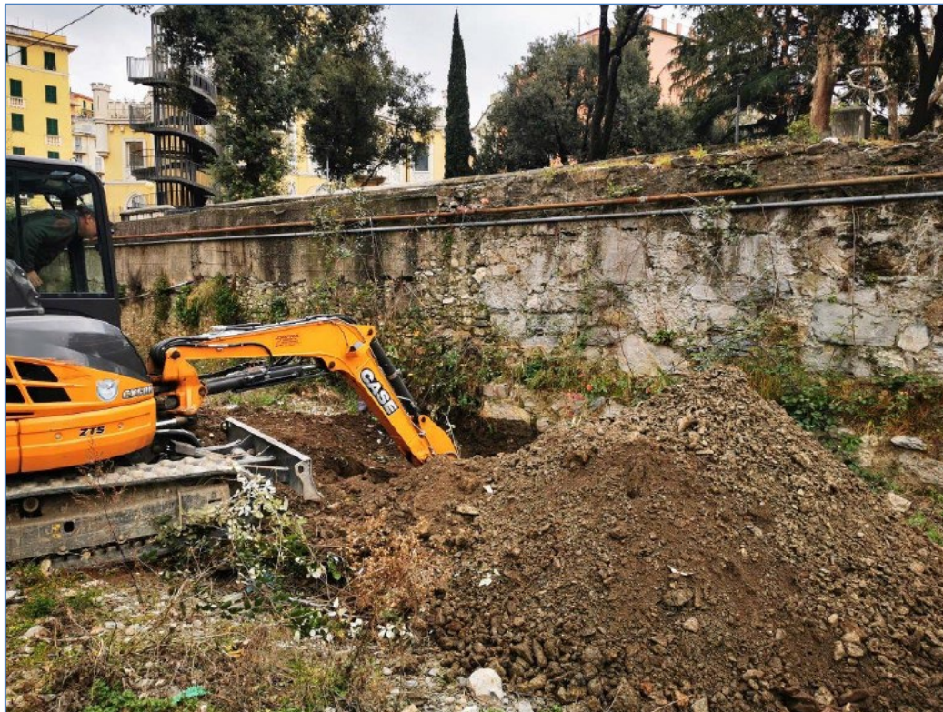
Foto 10.1 Scavo di un pozzetto esplorativo lungo il Rio Torbella
