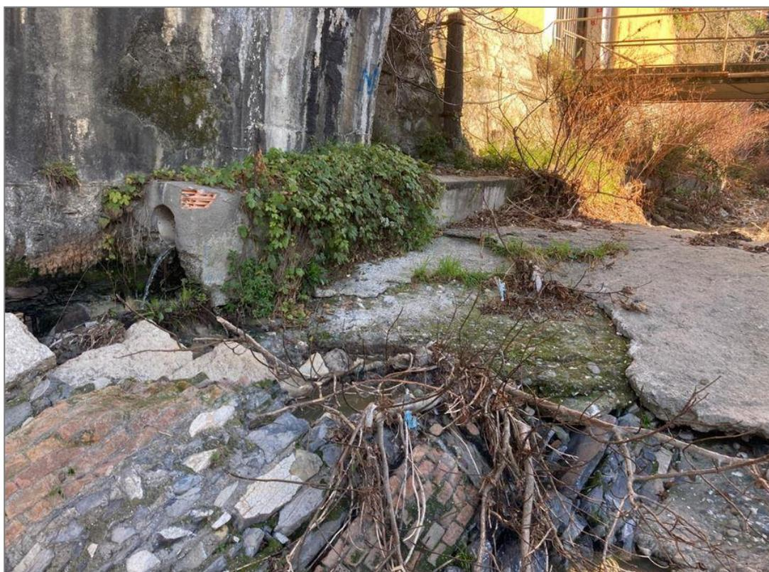
Figura 6.5 Scarico della fognatura in sponda destra del Torbella all'altezza della confluenza con il Polcevera
