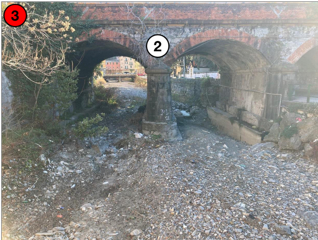
Figura 4-6: Ponte della linea ferroviaria Genova - Busalla che attraversa il Torbella, a partire da valle. Sullo sfondo il ponte di via Canepari, di cui si progetta la demolizione e ricostruzione a campata unica.
