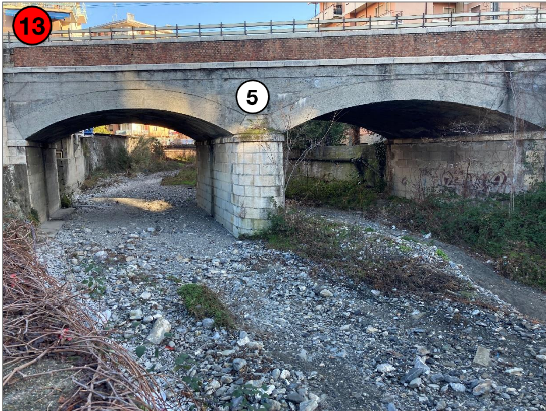
Figura 4-16: Ponte ferroviario della linea dei Giovi
