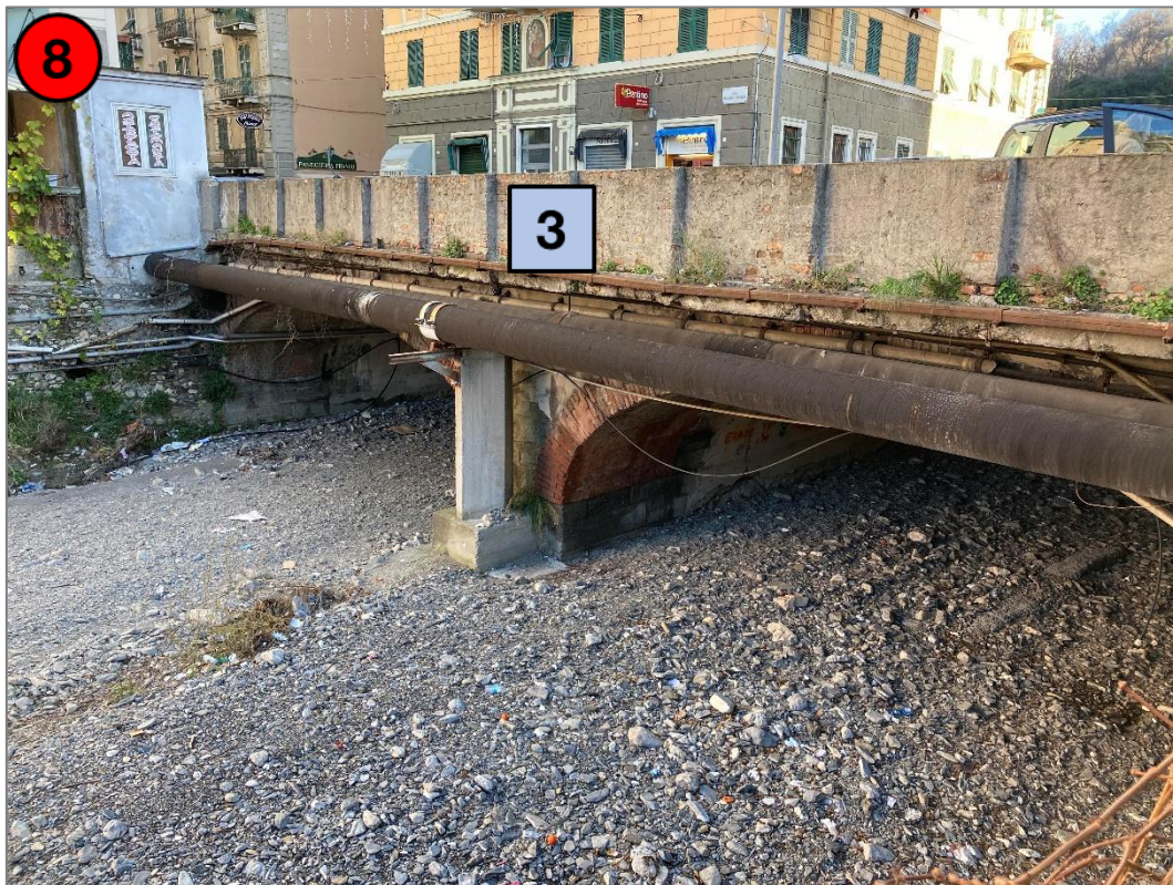
Figura 4-11: Ponte di via Canepari, vista da valle
