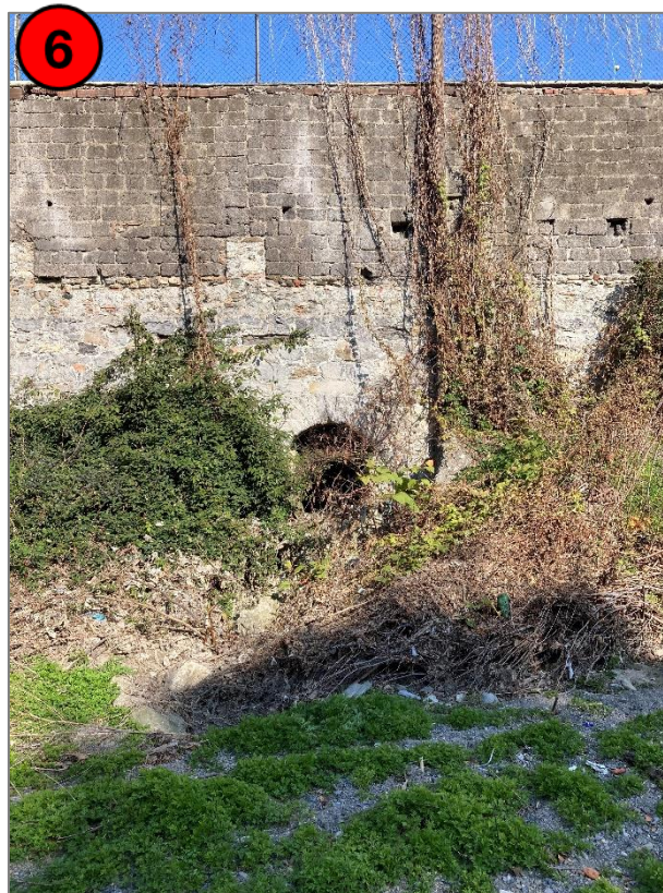
Figura 4-9: Muro di sponda in destra idraulica a monte del ponte ferroviario della linea Genova – Busalla.
