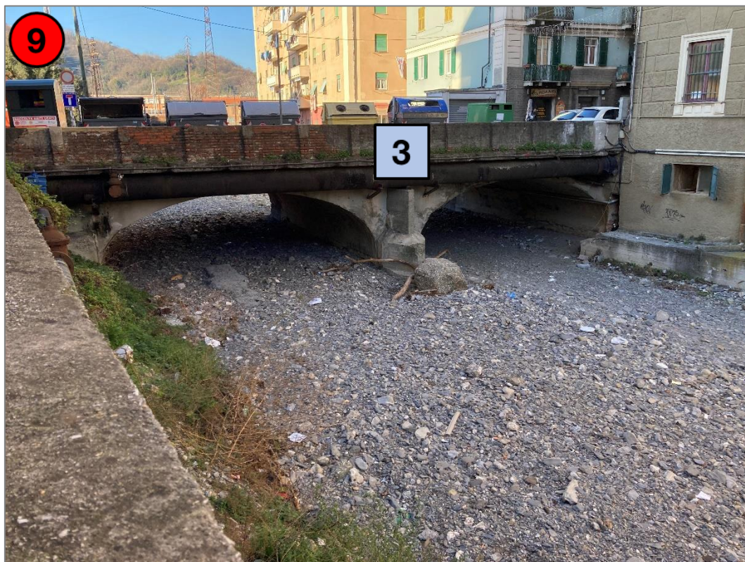
Figura 4-12: Ponte di via Canepari, vista da monte
