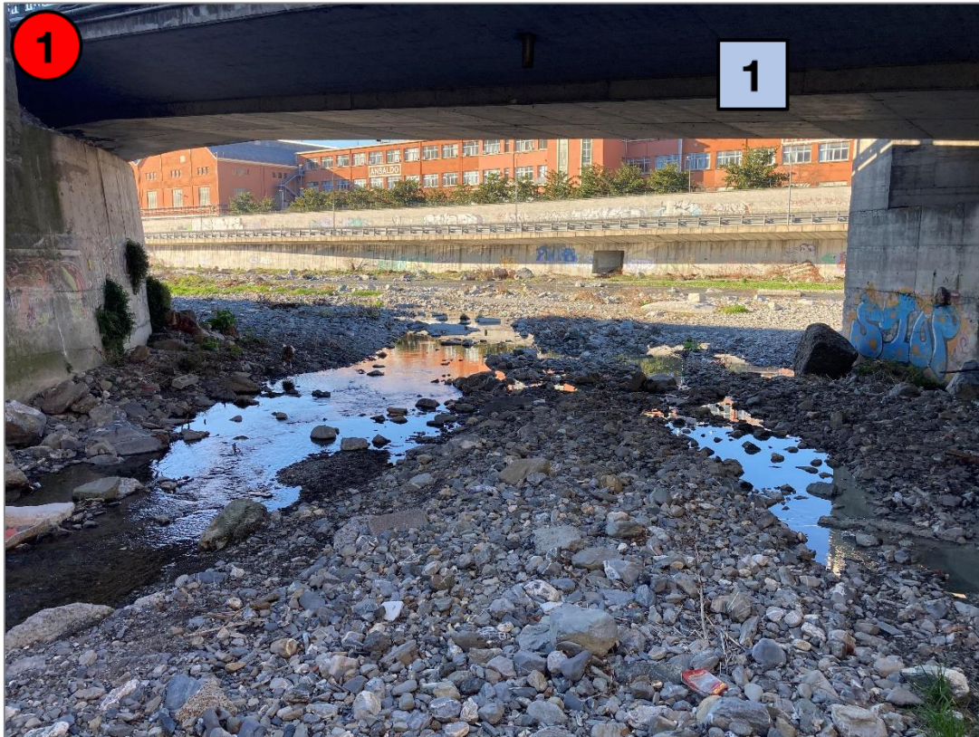
Figura 4-4: Confluenza del Torbella nel Polcevera e impalcato del ponte stradale di via Lungo Argine Polcevera.
