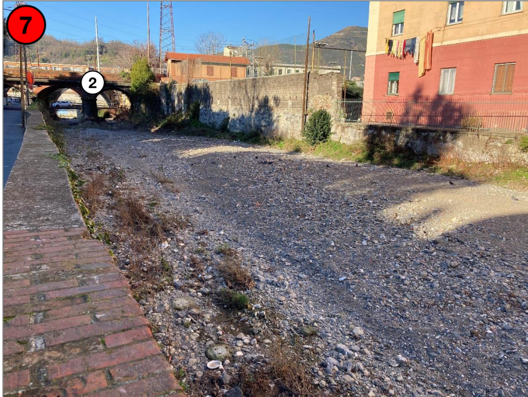
Figura 4-10: Torrente Torbella nel tratto tra il Ponte stradale di via Canepari e il ponte ferroviario della linea Genova - Busalla
