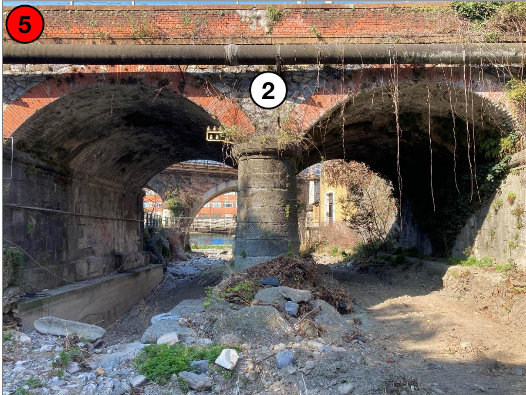
Figura 4-8: Ponte ferroviario della linea Genova – Busalla, visto da monte.
