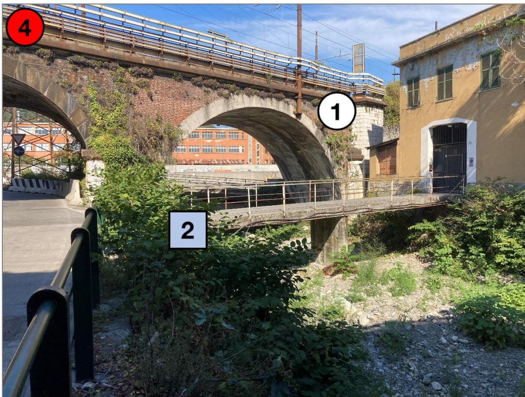
Figura 4-7: Torbella a monte del salto di fondo, attraversato dalla passerella carrabile. Sullo sfondo il ponte ferroviario della linea Succursale dei Giovi.
