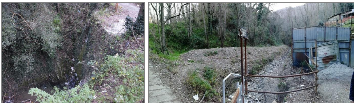
Figura 1-12: Sbarramento dell'alveo ed inizio strada privata
