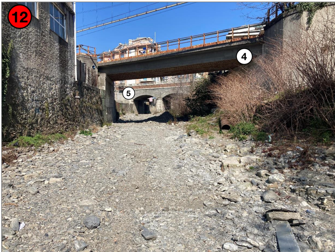
Figura 4-15: Alveo in prossimità dei campionamenti granulometrici effettuati. In secondo piano il ponte ferroviario della linea Bersaglio e sullo sfondo quello della linea dei Giovi
