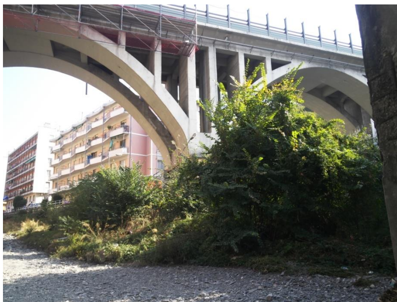
Figura 36- Ponte del viadotto autostradale. Area d'innesto dello scolmatore.
