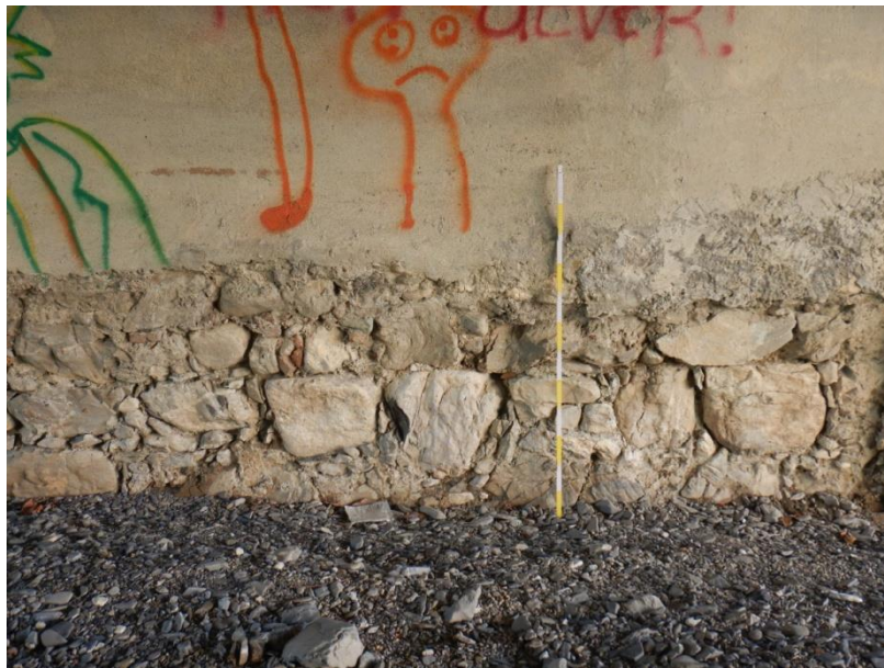
Figura 25- Particolare del corpo centrale del muro di spalla sinistra del ponte sul Torbella.
