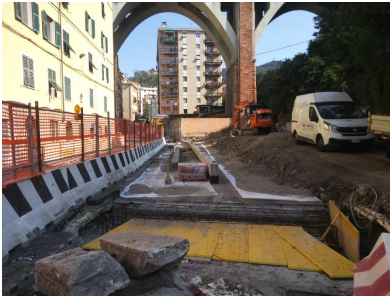
Figura 38- Attività di ripristino della copertura del rio Maltempo in corso.
