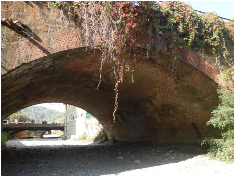
Figura 29- Ponte ferroviario Novecentesco.
