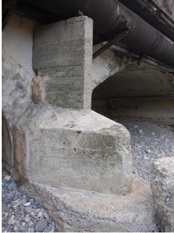
Figura 26- Pila centrale del ponte carrabile sul Torbella. Rostro centrale in cemento a monte.
