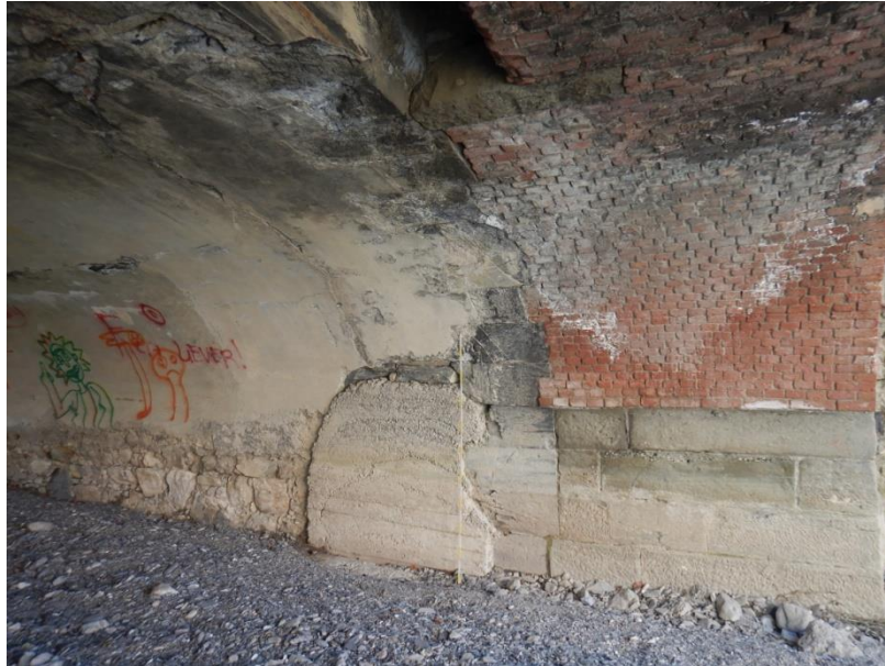
Figura 24- Arcata interna e spalla sinistra del ponte sul Torbella.
