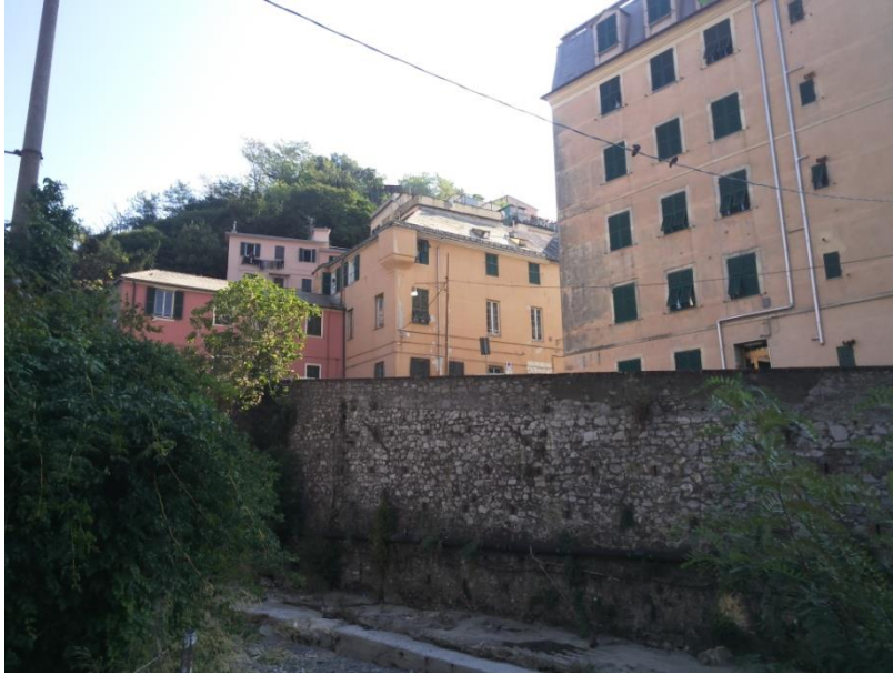
Figura 30- Argine sinistro del torrente su cui è stata edificata la rampa per raggiungere Palazzo Fieschi. Panoramica.
