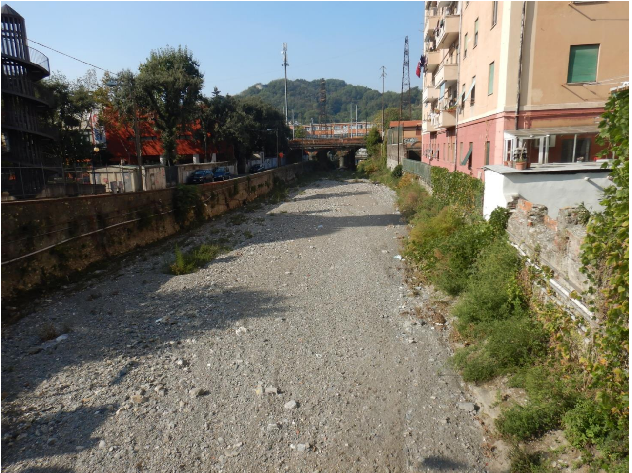
Figura 21- Tratto terminale del Torbella a valle del ponte carrabile.
