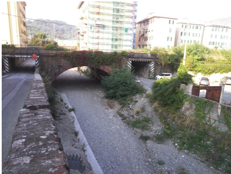
Figura 27- Ponte della Ferrovia fotografato dalla salita di Passo Torbella.
