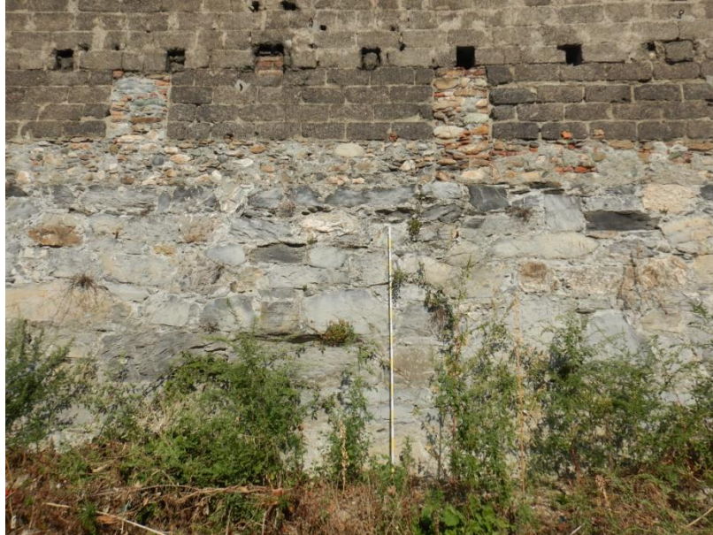
Figura 22- Argine in sponda destra del torrente Torbella.
