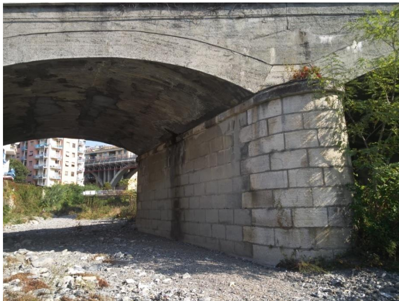
Figura 35- Particolare del ponte della ferrovia con pile foderate in arenaria.
