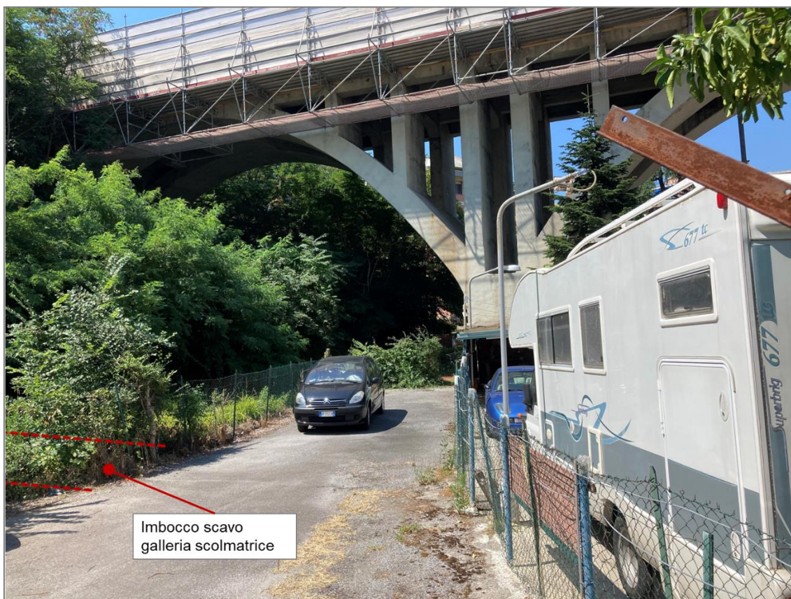
Figura 2-9: Vista allo stato attuale dell'area dove si prevede la realizzazione dell'imbocco della scavo in naturale per la galleria scolmatrice
