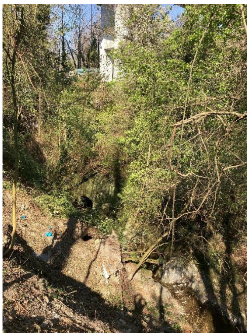
Figura 3-3 – Fotografia del terrapieno sotto il viadotto in corrispondenza dell’opera di presa de Maltempo
