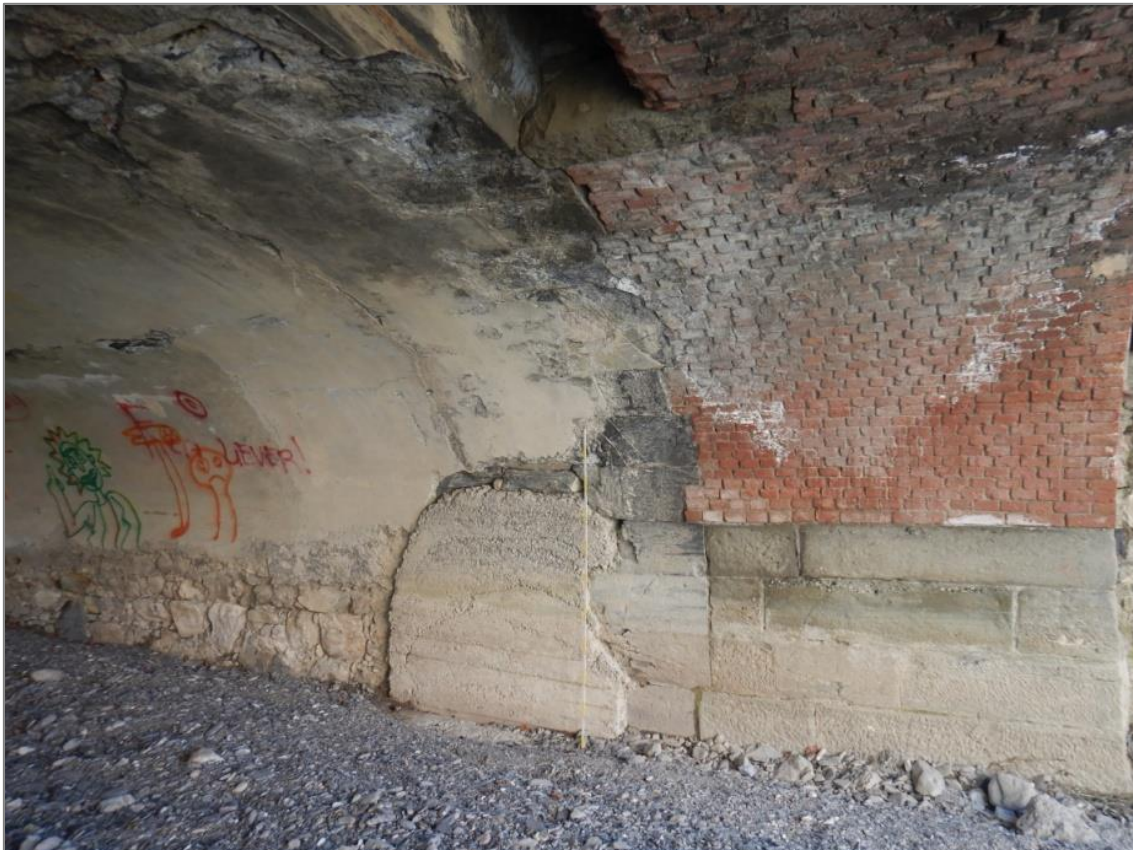
Figura 3-5: Arcata interna e spalla sinistra del ponte di via Canepari
