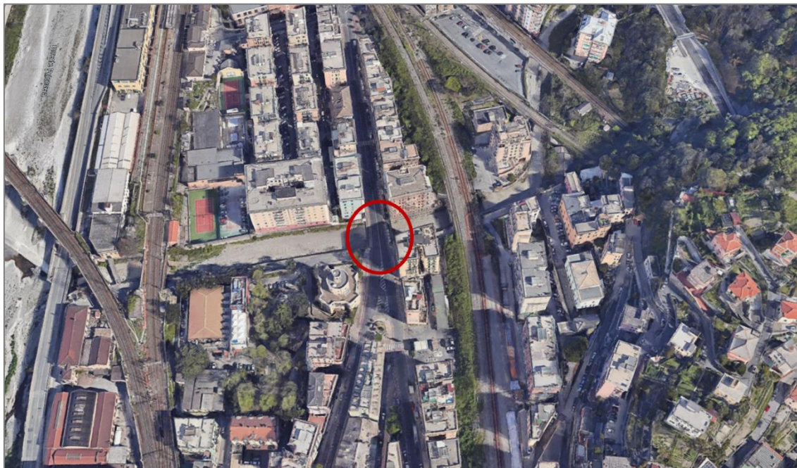
Figura 3-1: Inquadramento fotografico dell'opera oggetto di studio
