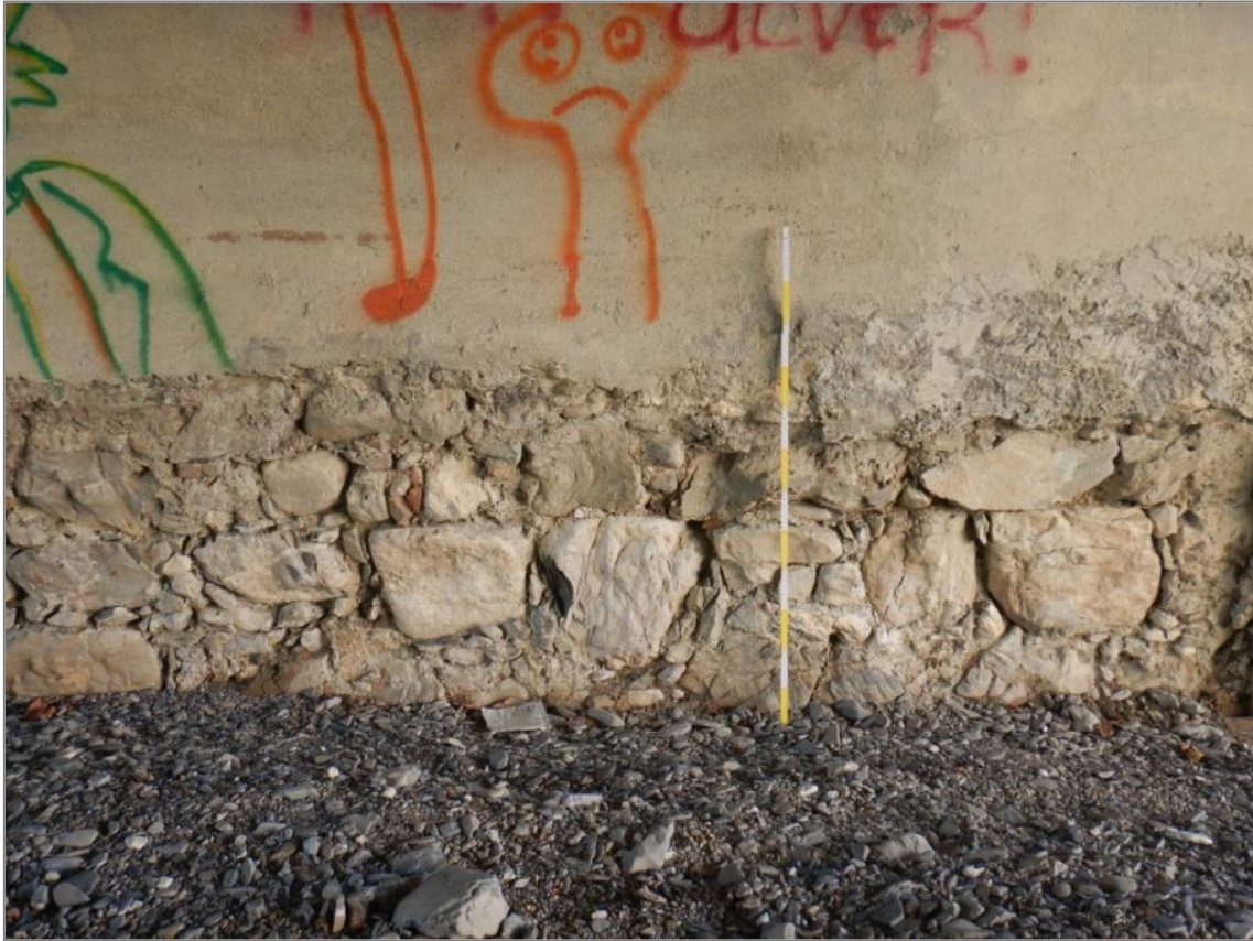
Figura 3-6: Particolare del corpo centrale del muro di spalla sinistra del ponte di via Canepari
