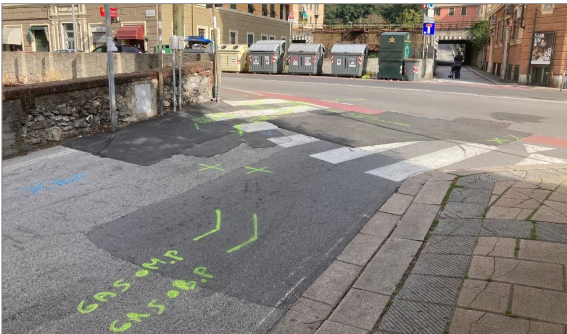
Figura 2-19: Vista dell'area a valle della spalla sud del ponte di via Canepari, con l'evidenza delle condotte del gas presenti a seguito del tracciamento eseguito da Ireti
