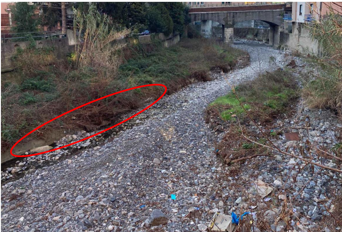
Figura 2-13: Vista del t. Torbella dal ponte di via Fasciotti verso valle. Il manodotto si trova parzialmente interrato in sinistra idraulica (evidenziato dall'ellisse in rosso)
