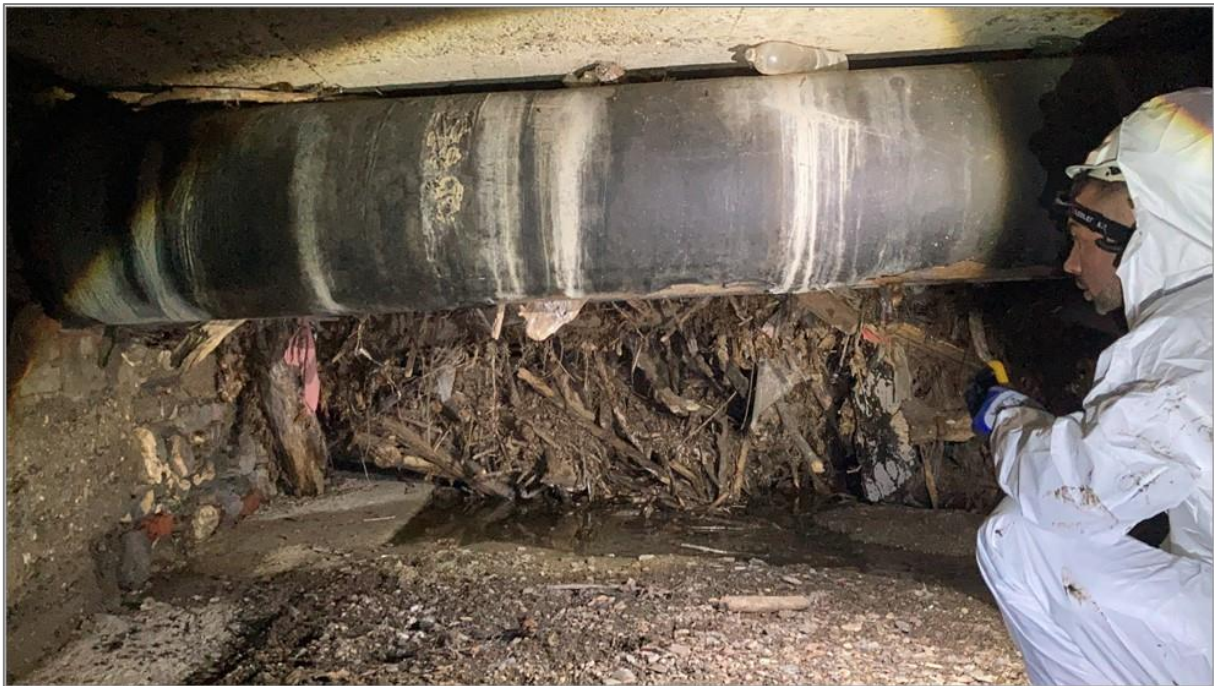
Figura 2-2: Fotografia dell'interferenza determinata dalla condotta Ireti – rete gas (DN 500) presente al di sotto di via Canepari
