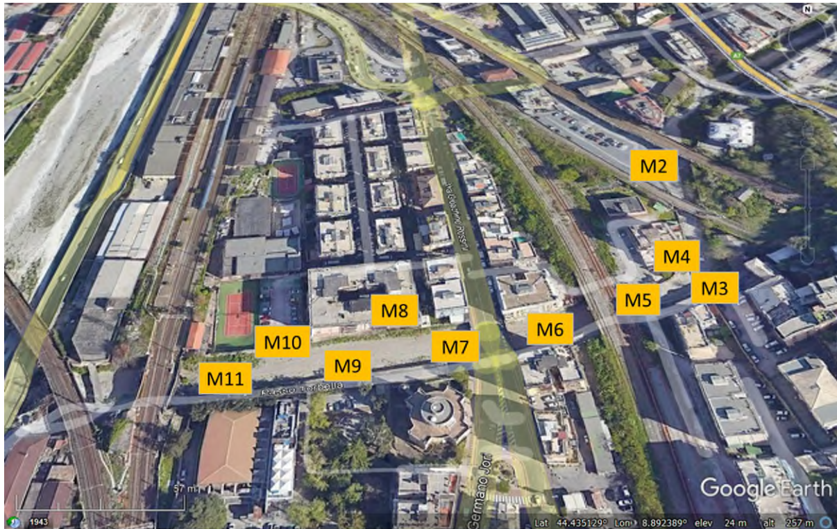
Figura 5.7 Muri esistenti lungo il torrente Torbella interessati dal monitoraggio degli spostamenti.
