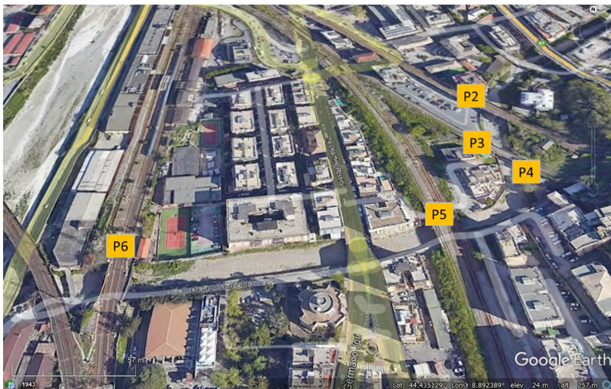
Figura 5.6 Ponti esistenti lungo il torrente Torbella interessati dal monitoraggio degli spostamenti.
