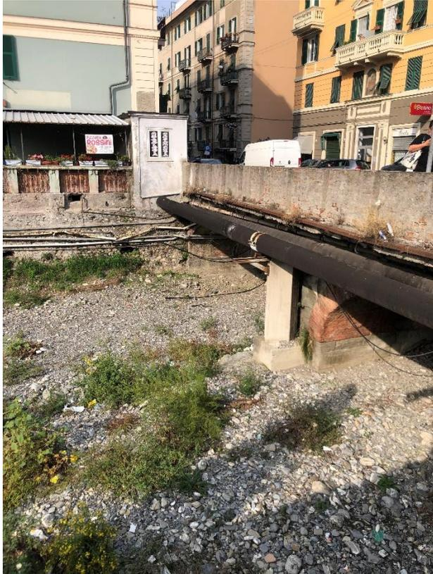
Figura 10 – Condotte DN 400 mm in attraversamento al Torbella in corrispondenza del ponte di via Rossini
