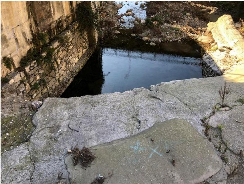
Figura 6 – Salto di quota allo sbocco del Torbella e tracciamento a terra condotta DN 500 mm
