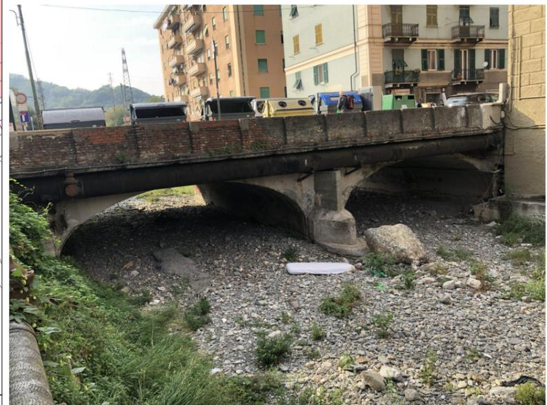
Foto 2: interferenza A.4 - acquedotto DN 600 ACC staffato sul ponte di via Canepari (lato monte)
