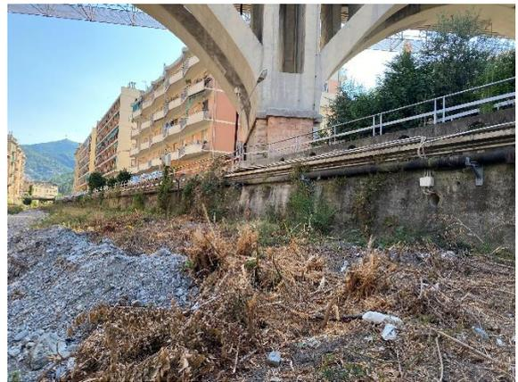
Figura 2 – DN 200 mm staffato in sx idraulica del Torbella
