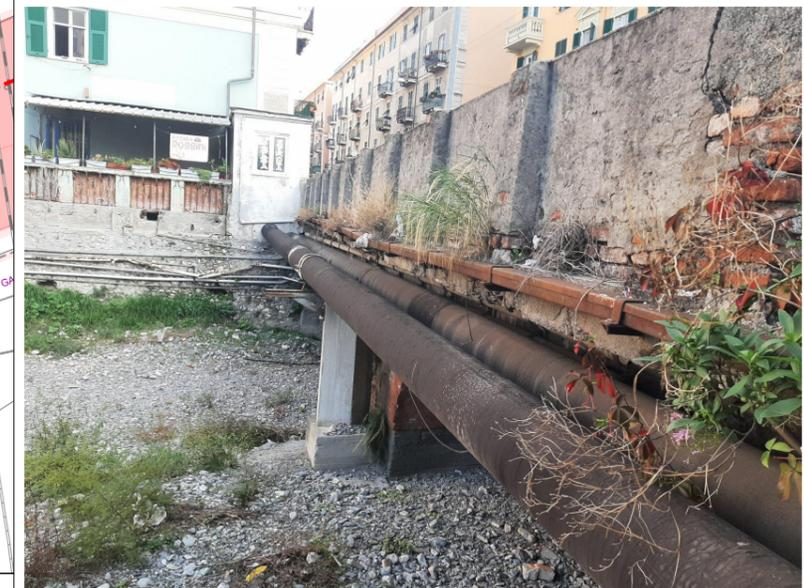
Foto 8: interferenza G.3 - G.4 - condotte GAS MP e GAS BP staffate sul ponte di via Canepari (lato valle)
