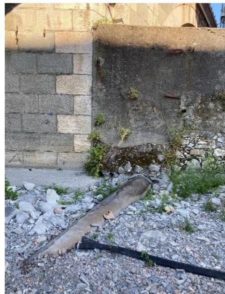
Figura 4 – DN 500 mm in attraversamento al torbella
