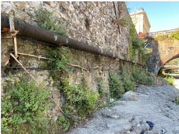
Figura 1 – DN 200 mm staffato in sx idraulica del Torbella
