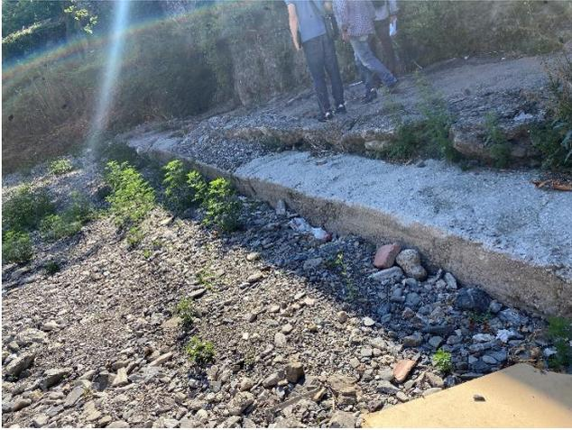
Figura 8 – condotta in sub alveo su bauletto in cls
