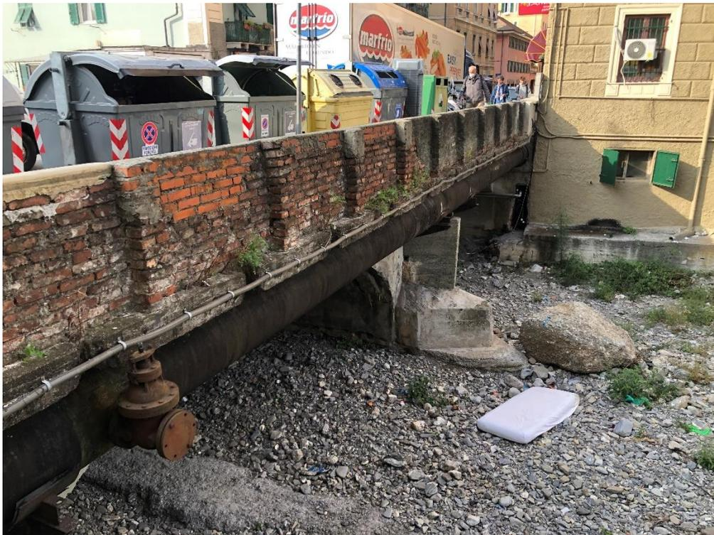
Figura 5 – DN 600 mm staffato al ponte esistente di via Rossini
