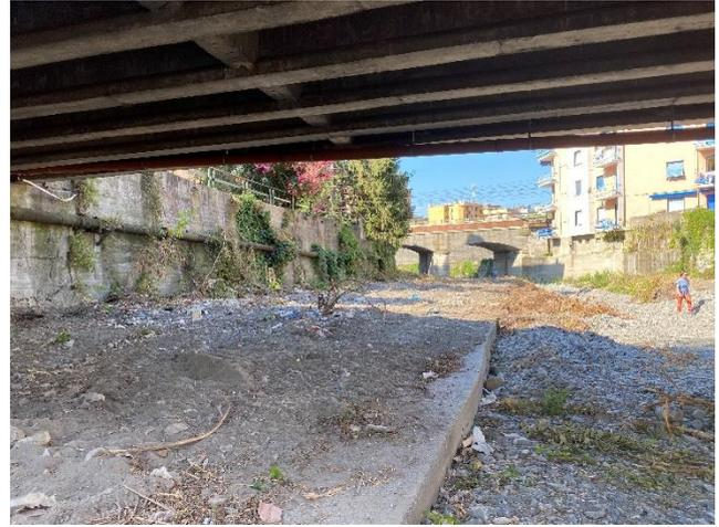
Figura 9 - condotta in sub alveo su bauletto in cls
