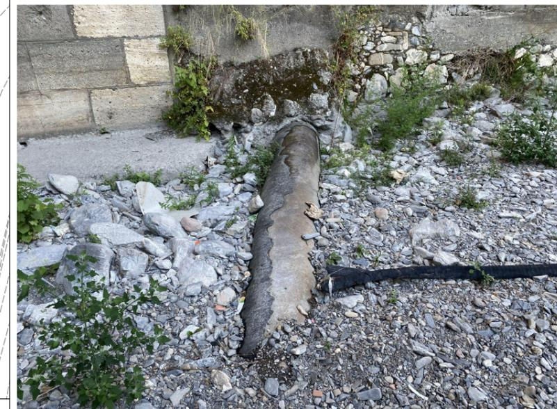
Foto 1: interferenza A.3 - acquedotto DN 400 ACC posato su alveo Torbella
