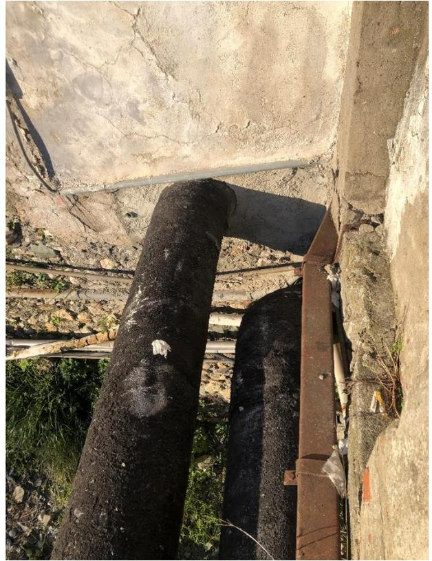
Figura 11 – Particolare ingresso condotte DN 400 mm lato nord, al di sotto dell'edificio previsto in demolizione
