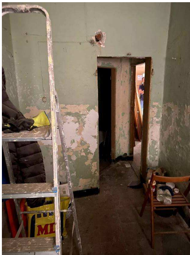
Foto 4 - Stato attuale interni
