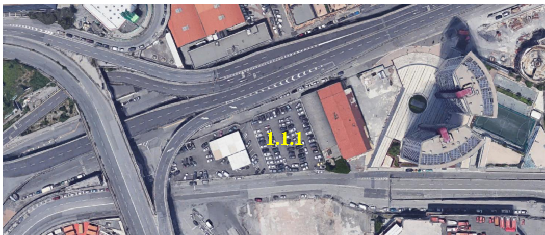
- VISTA AEREA DEL LOTTO 1.1.1 -
