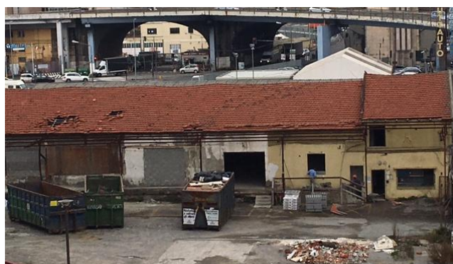
- VISTA DI DETTAGLIO DEL PROSPETTO DI LEVANTE -
