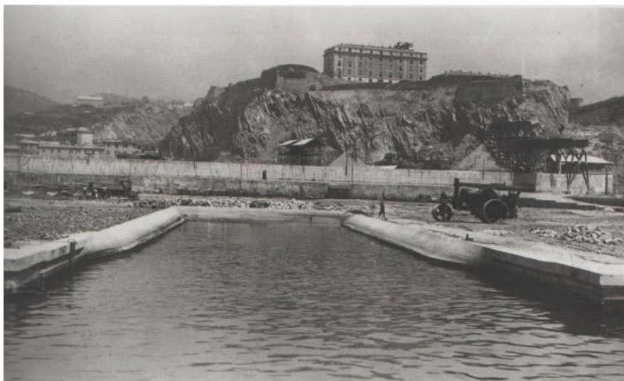
Qui vediamo la costruzione di Ponte Idroscalo effettuata cavando pietra e detriti dal Colle di San Benigno. Sulla sinistra si possono notare le strutture in ferro utilizzate per l'estrazione ed il trasporto dei materiali dalla cava.
