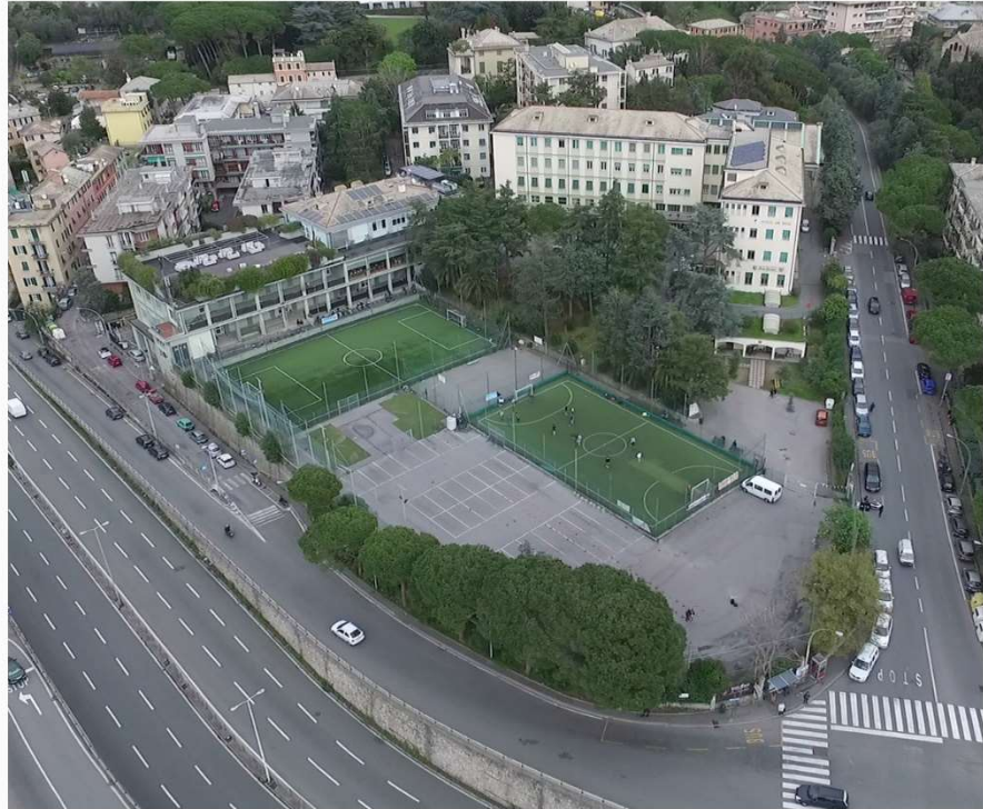
fig.2 – Vista dall'alto dello stato attuale della zona di intervento.
