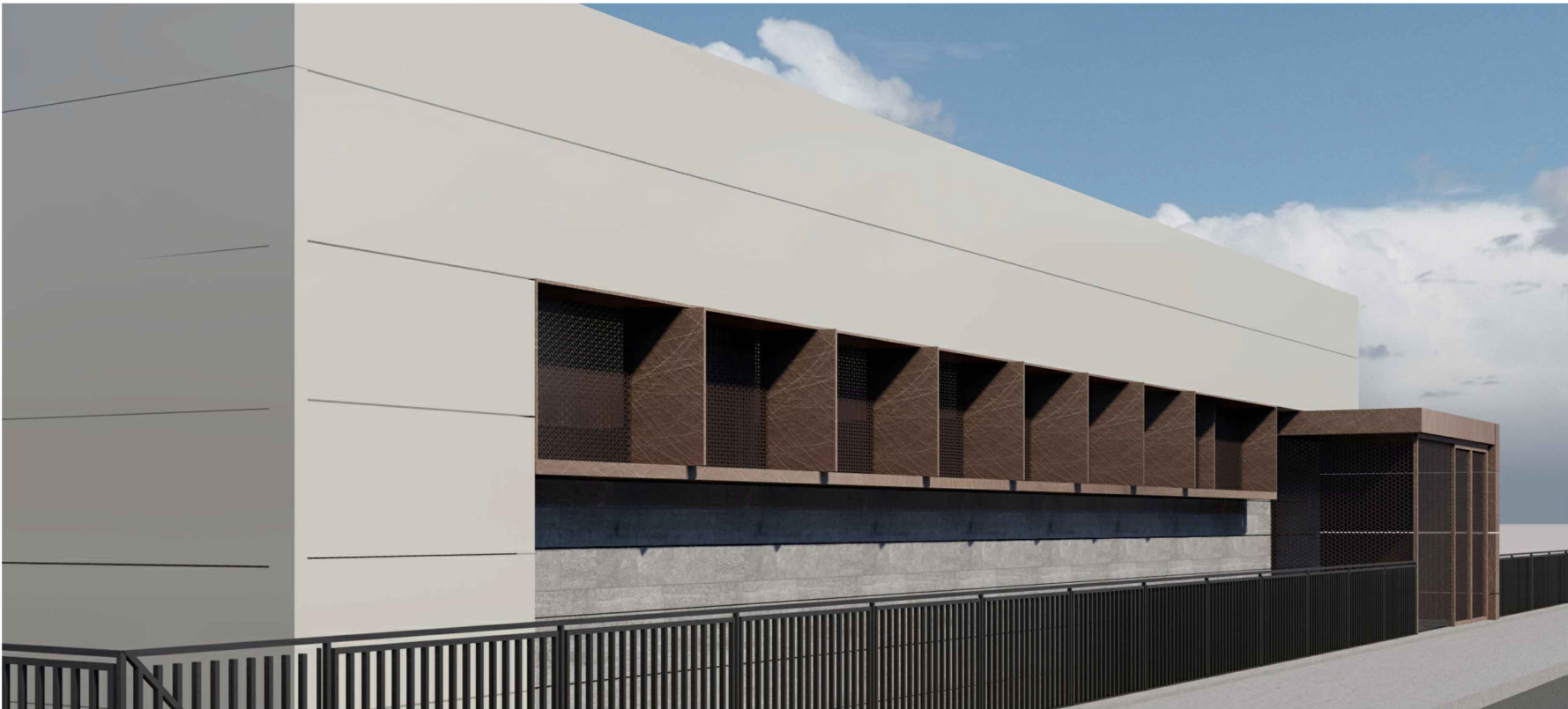
LOCALI TECNICI STAZIONE STADIO MARASSI: VISTA DAL MARCIAPIEDE
