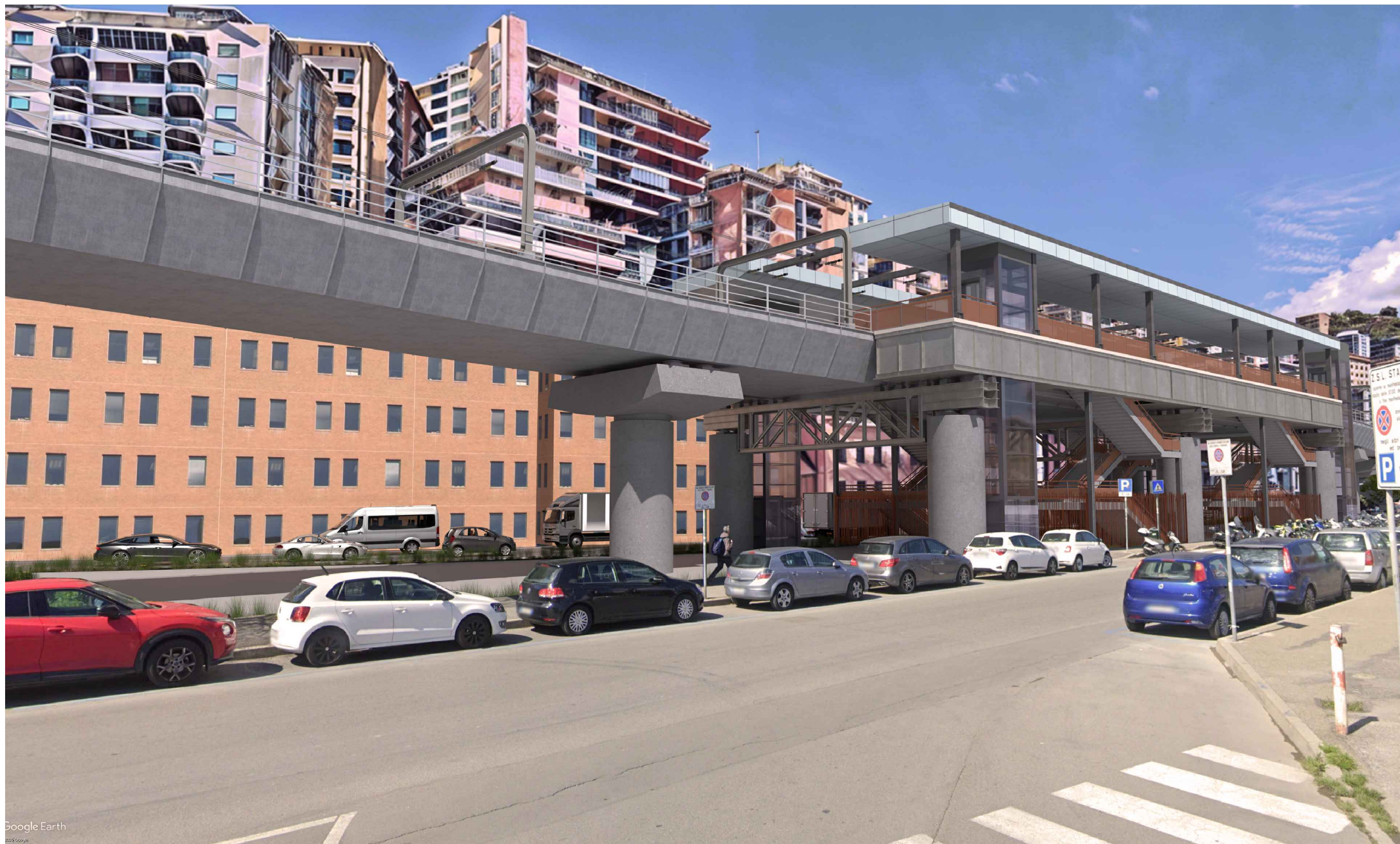
STAZIONE STADIO MARASSI - VISTA DAL BASSO LATO SUD
