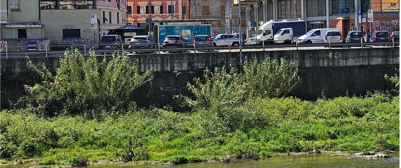
Figura 74 – Dettaglio argine destro con sopraelevazione in cemento armato
