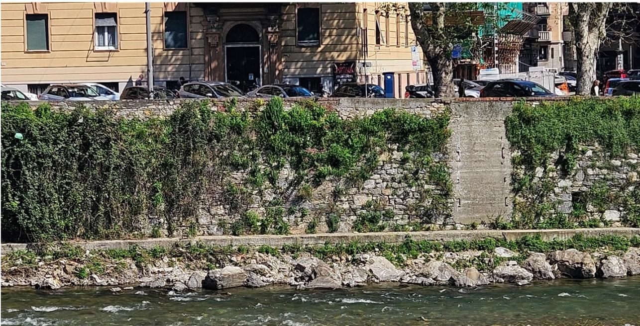
Figura 94 – Dettaglio argine in pietra con elementi puntuali in cemento armato
