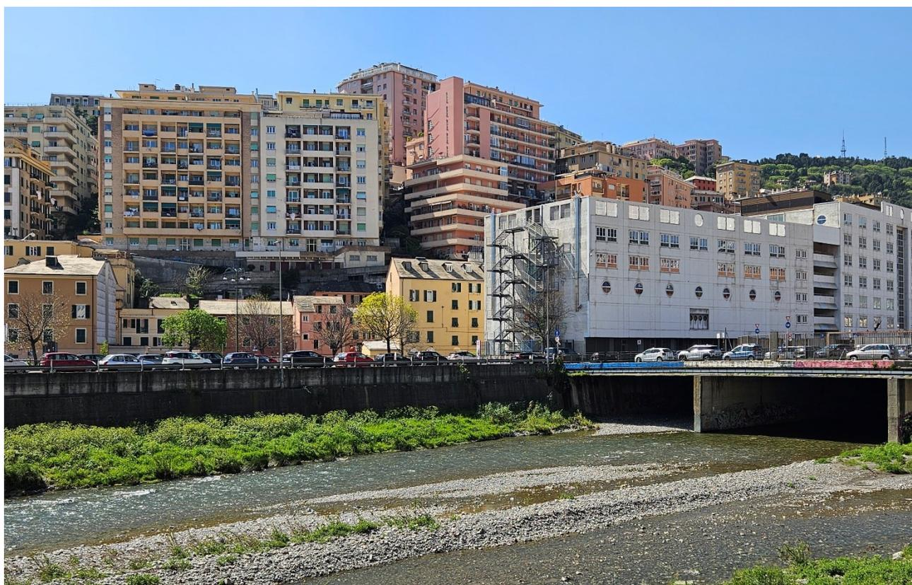
Figura 71 – Argine destro con sopraelevazione in cemento armato
