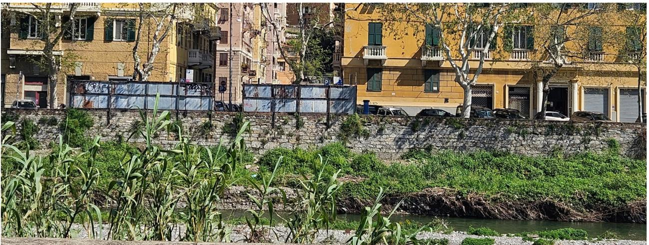
Figura 97 – Dettaglio argine sponda sinistra e parapetto in conci di pietra non rimaneggiato
