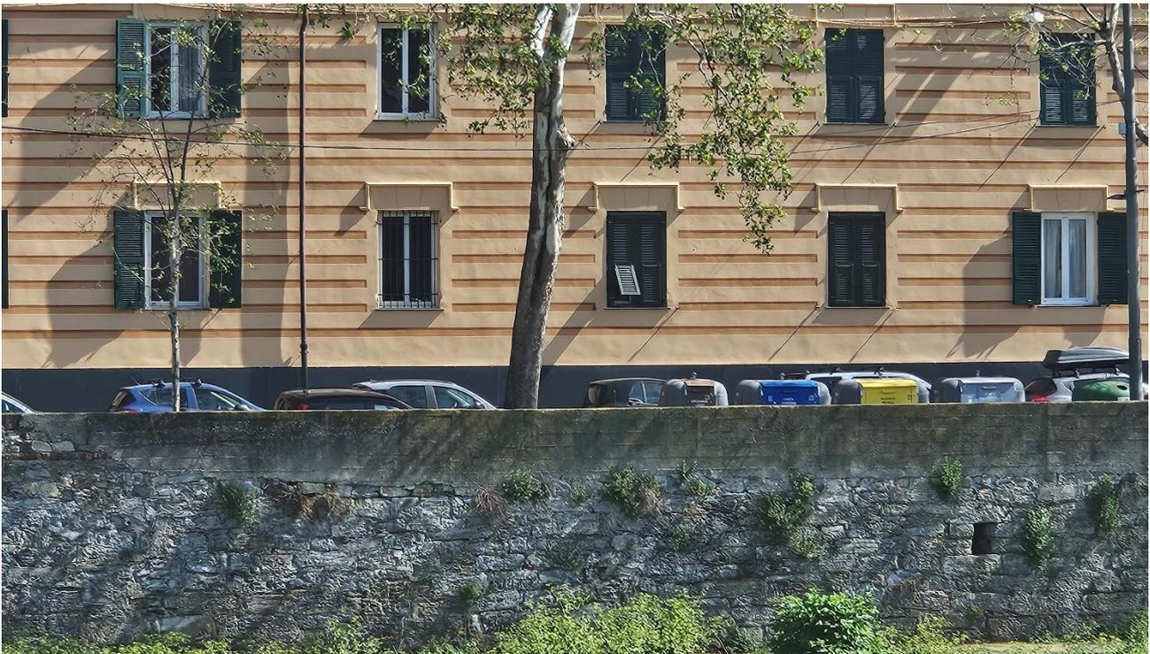
Figura 100 – Dettaglio parapetto in muratura mista intonacato a malta di cemento con tratto rifatto in c.a.
