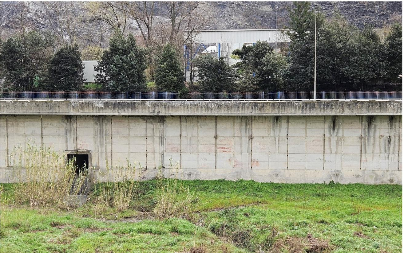
Figura 29 – Dettaglio argine in cemento armato
