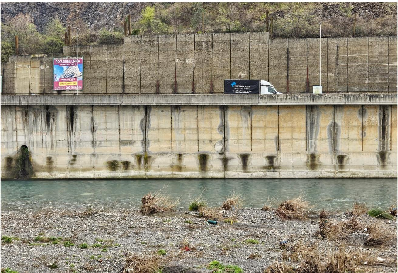
Figura 31 – Dettaglio argine sponda sinistra in cemento armato
