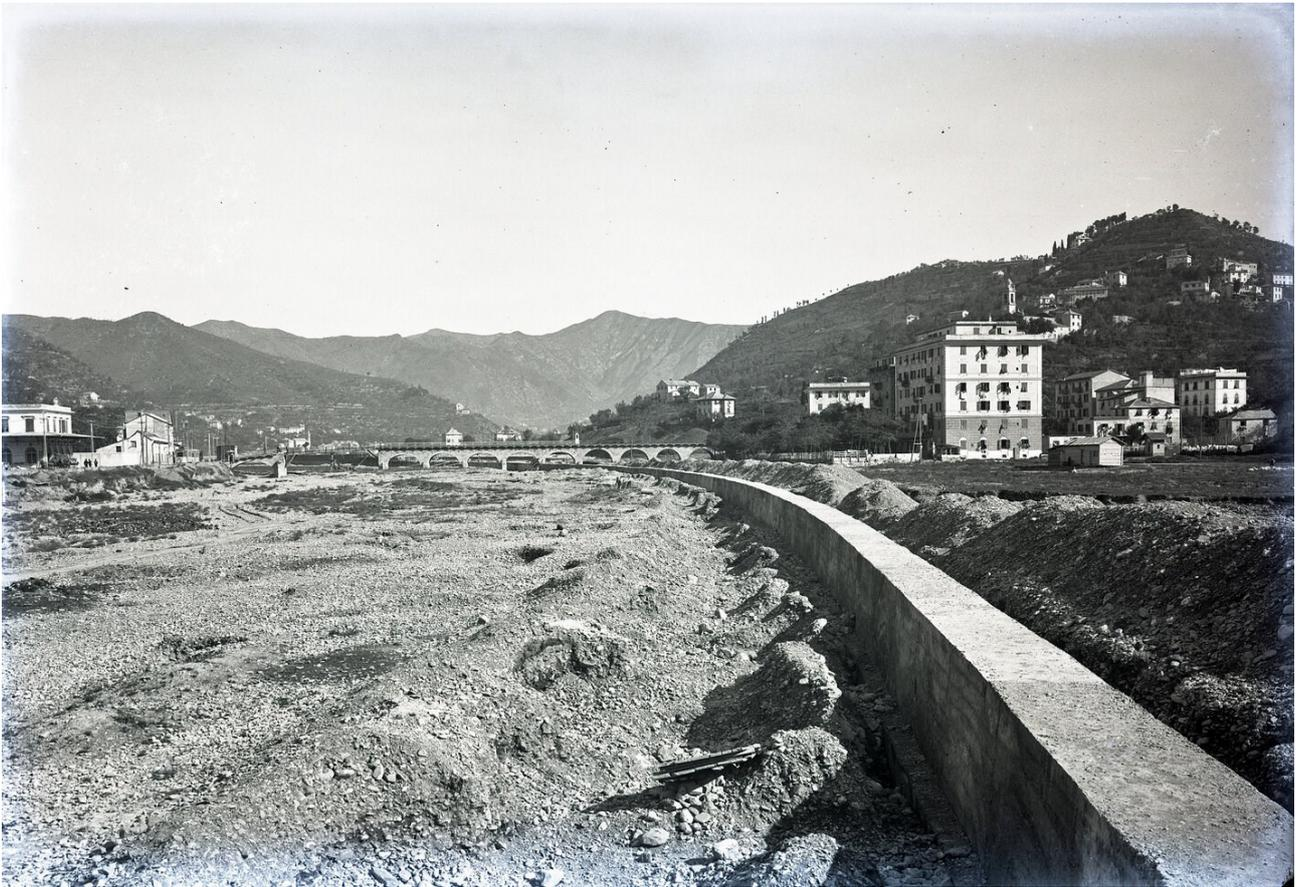
Figura 17 – Foto storica arginatura Bisagno a valle del ponte Carrega
