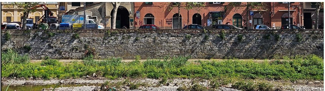
Figura 98 – Dettaglio argine sponda sinistra e parapetto in conci di pietra non rimaneggiato
