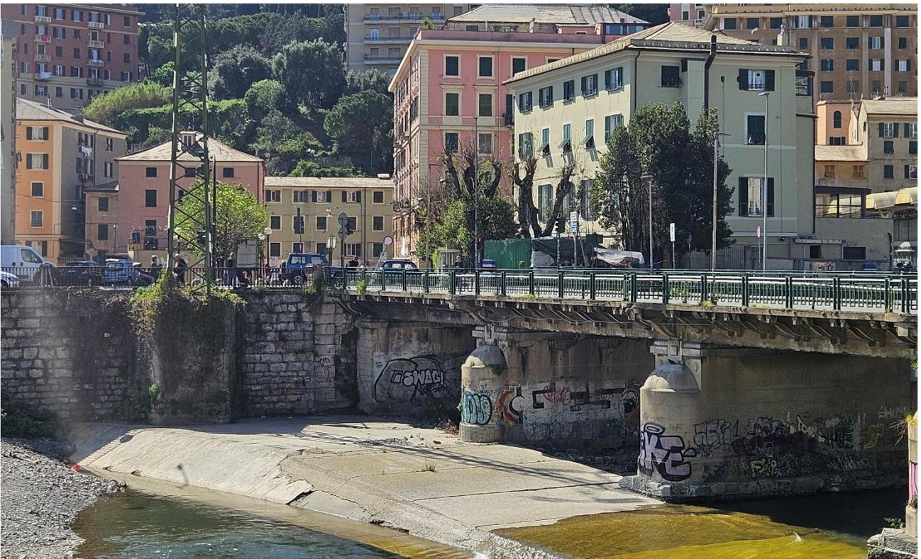
Figura 75 – Ponte Serra, argine in pietra con manufatti in cemento armato aggiunti
