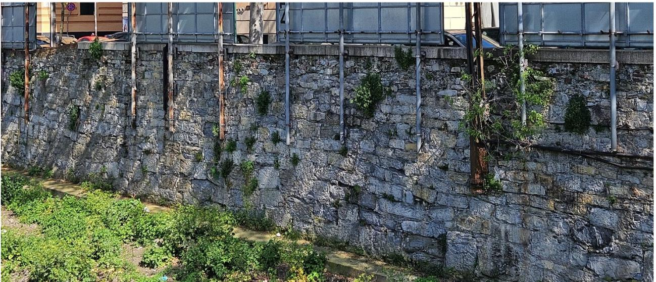
Figura 99 – Dettaglio argine sponda sinistra e parapetto in conci di pietra non rimaneggiato
