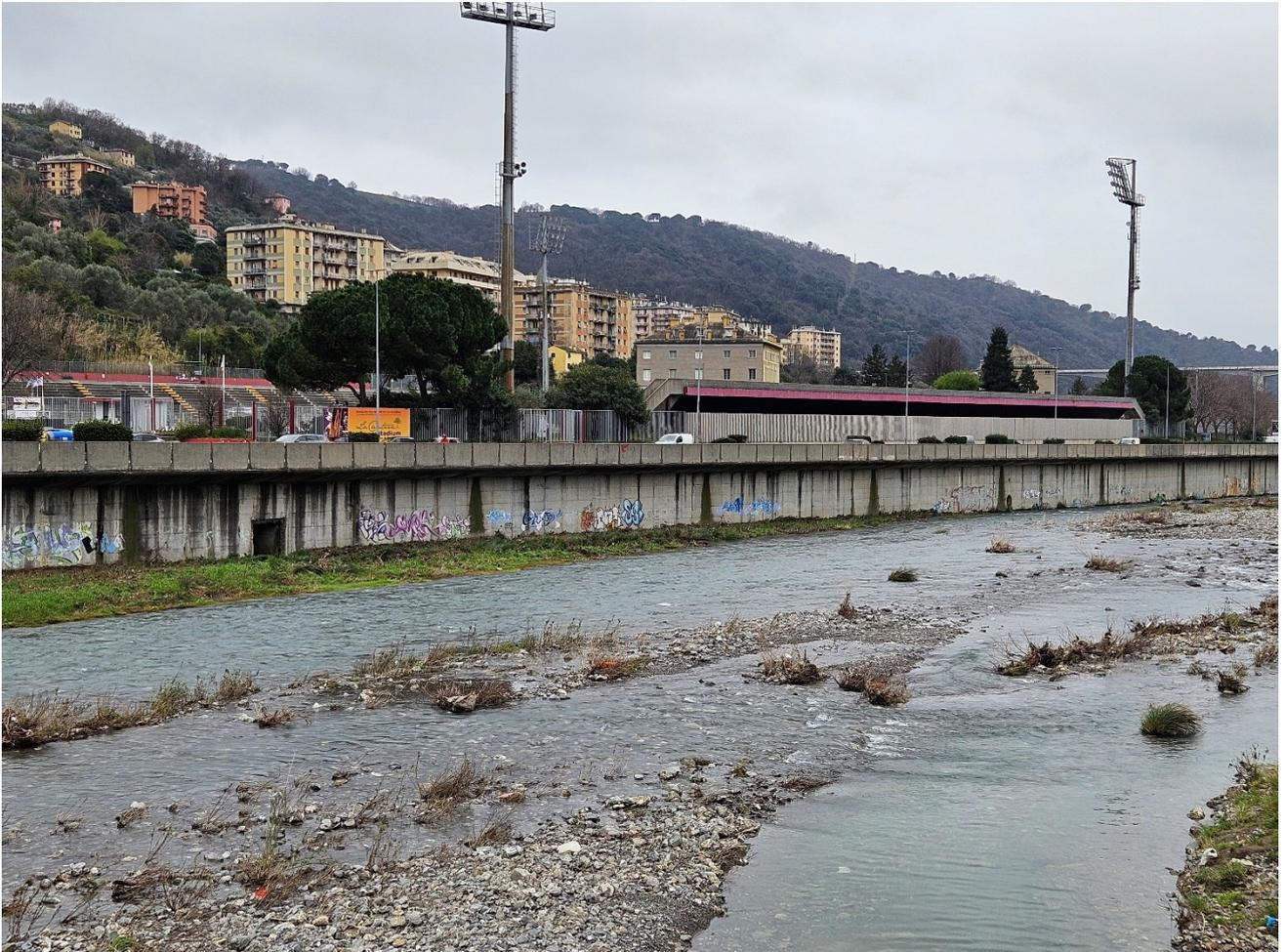
Figura 32 – Argine sponda sinistra in cemento armato
