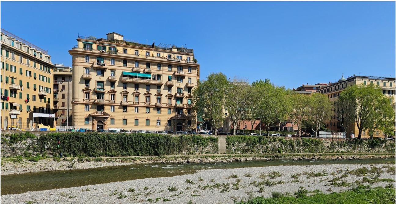
Figura 93 – Argine sponda sinistra in pietra con elementi puntuali in cemento armato
