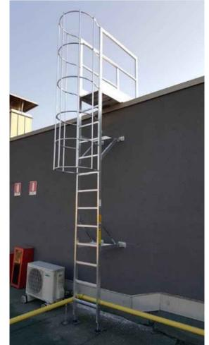
SISTEMA DI PROTEZIONE DI BORDO: PARAPETTO RIBALTABILE DI PROTEZIONE
