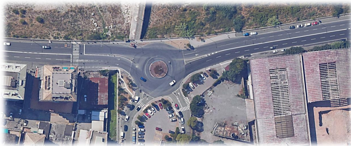
Figura 26. Rotatoria in prossimità Via Ponte Carrega – Stato di fatto
