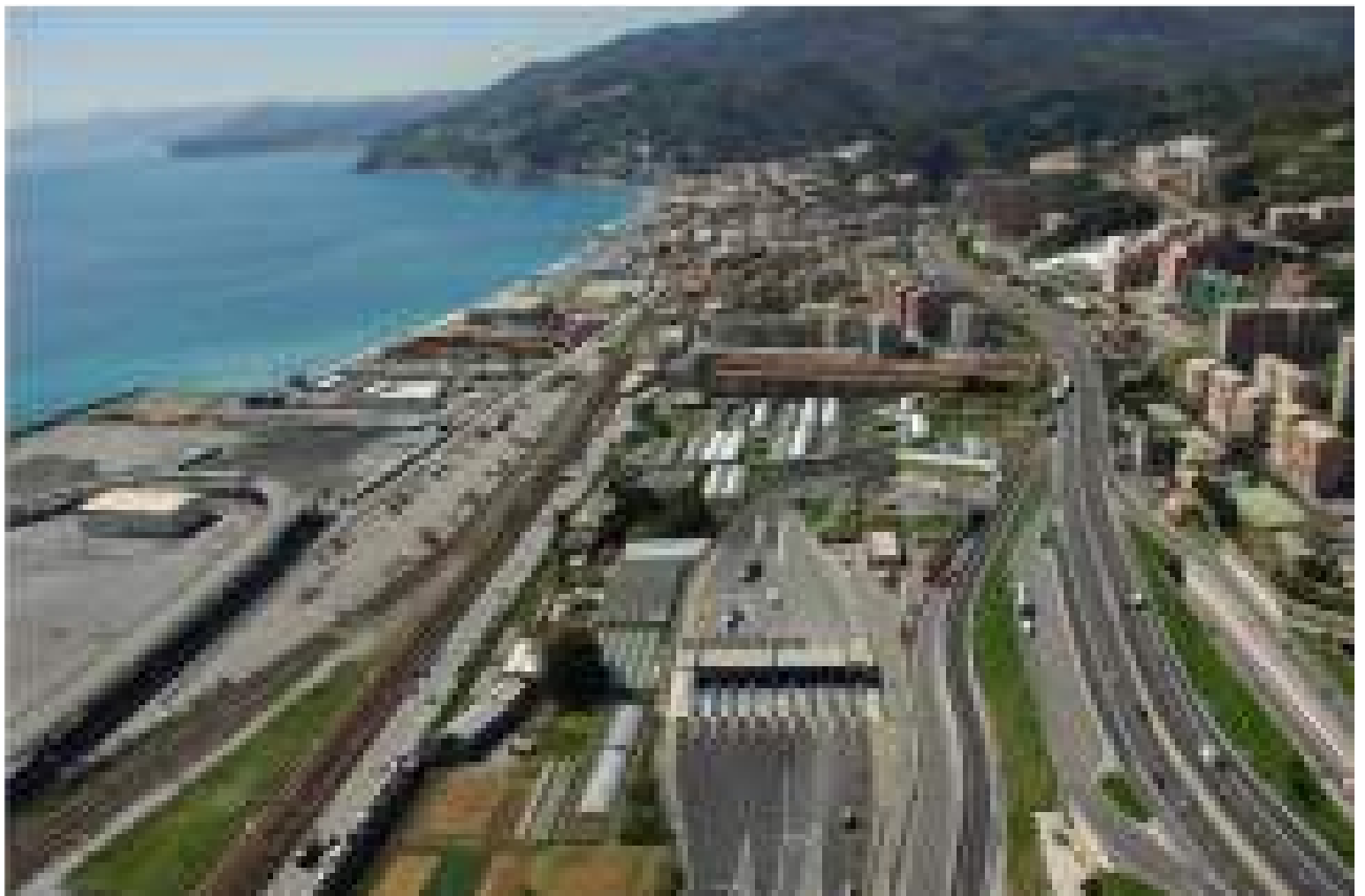
FOTO 2. VEDUTA AEREA DA LEVANTE
