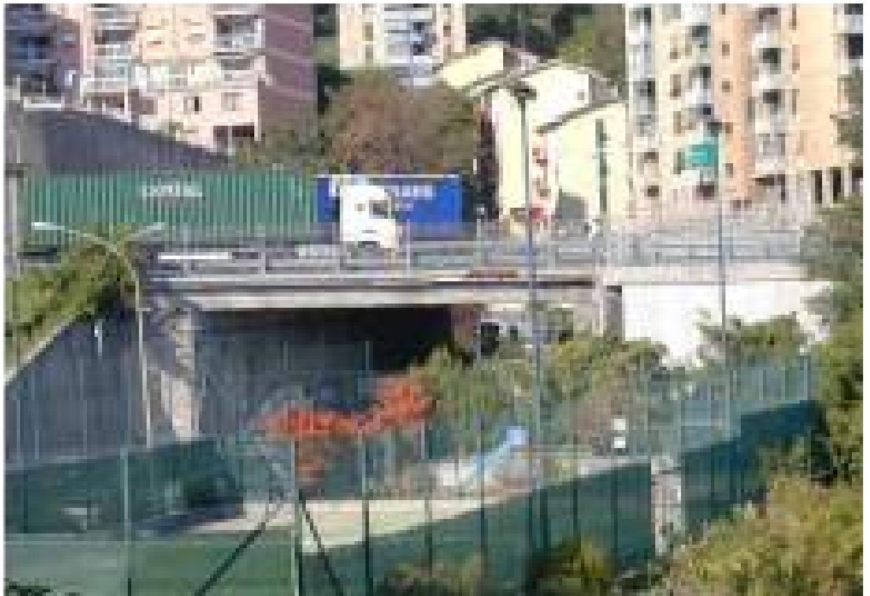
FOTO 18. L'AUTOSTRADA GENOVA-VENTIMIGLIA AL CONFINE NORD DELL'AREA
