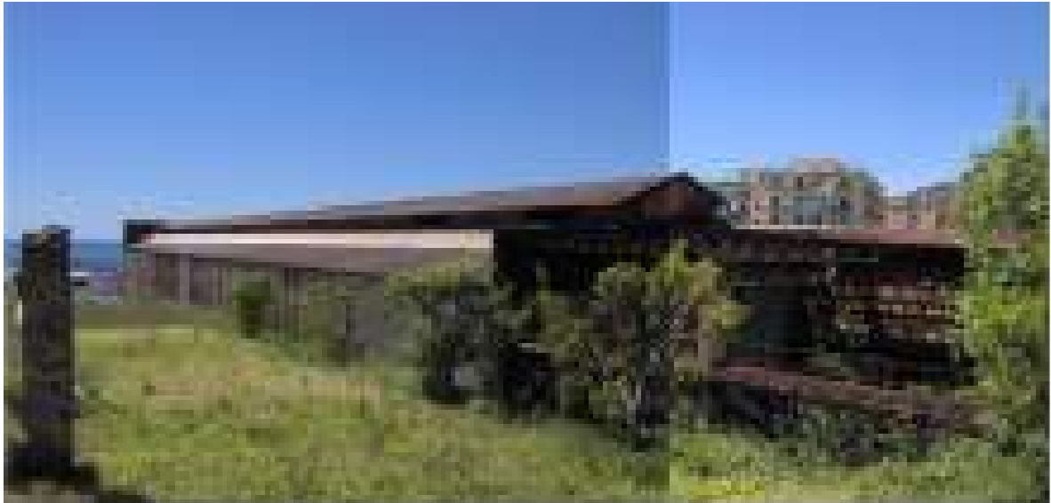
FOTO 19. CAPANNONI VISTI DALL'AREA DELLE SERRE DI PRA'
