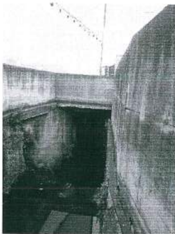
Foto 8: Imbocco tombinatura via Voltri
