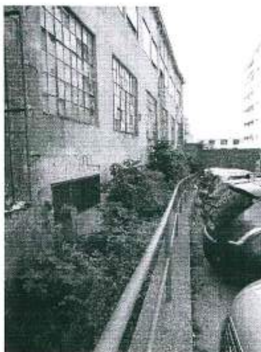
Foto 5: Tratto compreso tra via Ventimiglia e via Voltri
