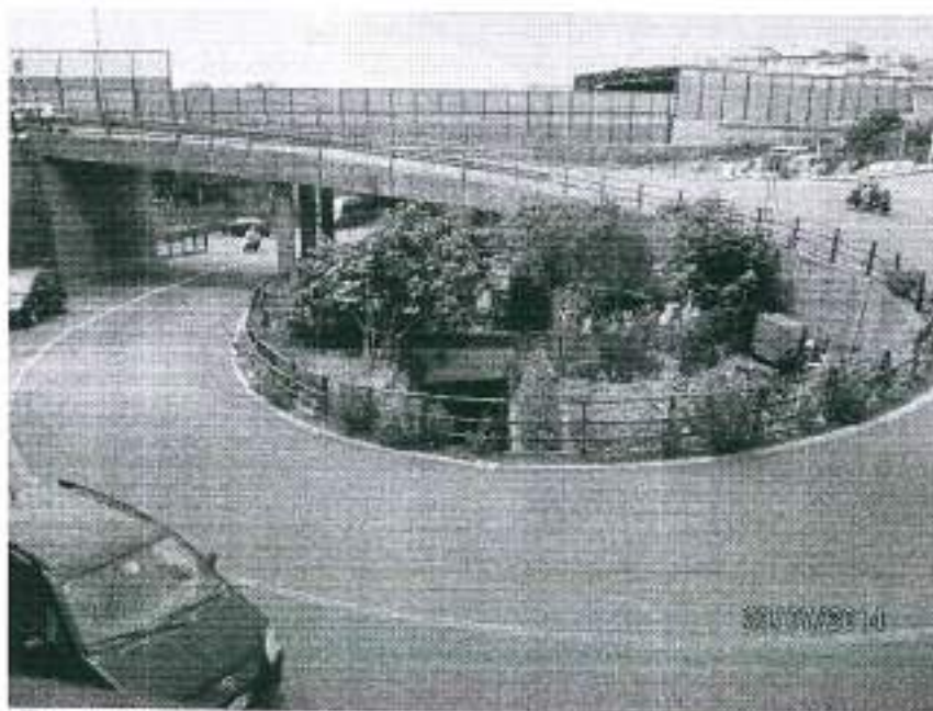
Foto 1: Tratto compreso tra via Ventimiglia e viadotto di via Cravasco
