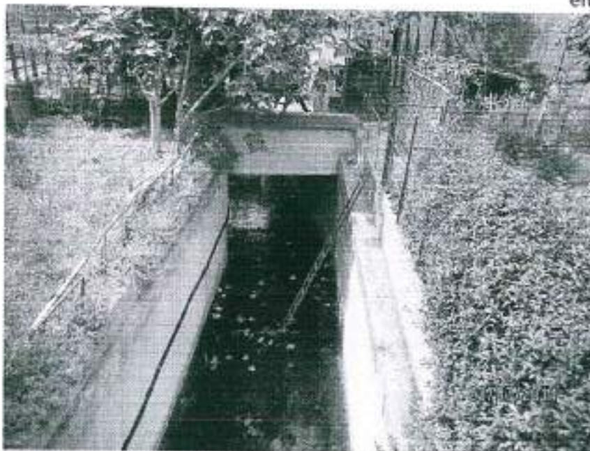
Foto 2: Imbocco breve tratto tombinato in corrispondenza del viadotto di via Cravasco
