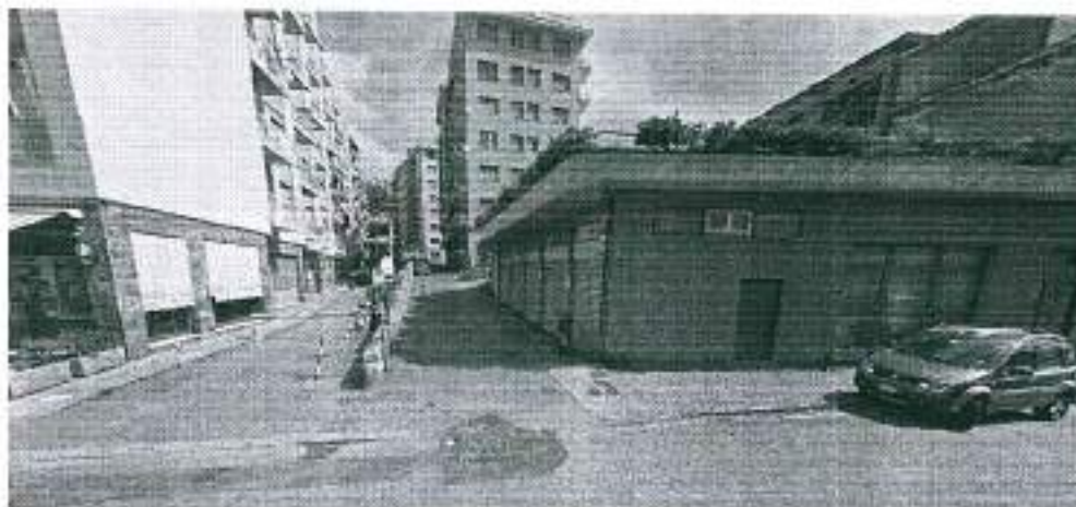
Foto 13: Accesso aree sponda destra da via Voltri
