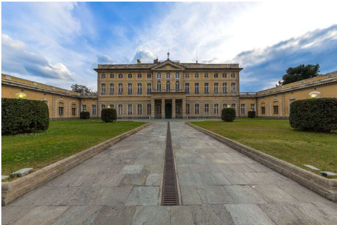
Villa Durazzo Bombrini, ingresso lato nord
