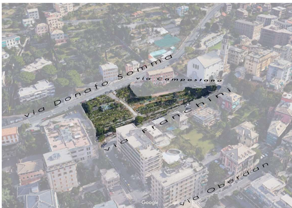
Fig. 2 – Vista generale dall'alto con evidenziata la zona di intervento.
