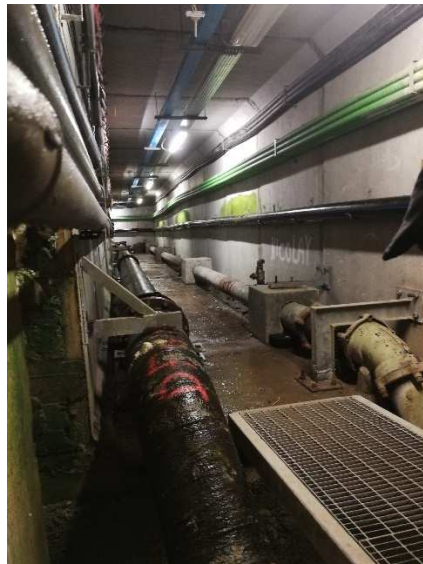
Figura 6.3 - Cunicolo tecnologico sotto Piazza De Ferrari.
