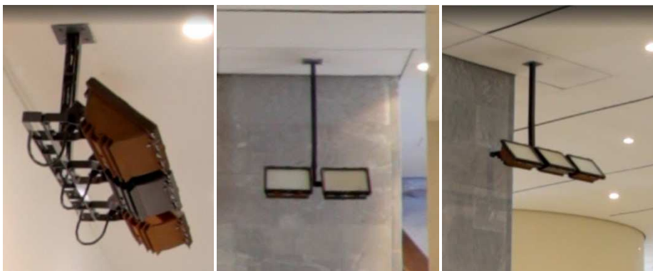
Figura 9.4 – Proiettori con lampada alogena da 750 W.
