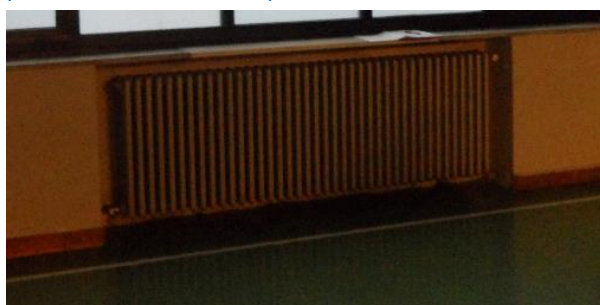
Figura 4.7 – Particolare dei radiatori installati nella palestra dell'istituto, su parete esterna.
