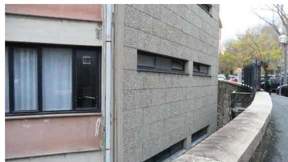
Figura 4.2 - Particolare della facciata rivestita in pietra, rivolta a sud/est.
