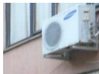
Figura 4.14 - Particolare di un sistema monosplit
