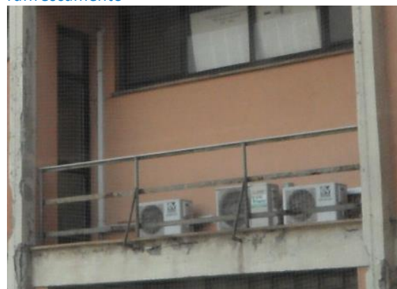
Figura 4.13 - Particolare del sistema di raffrescamento
