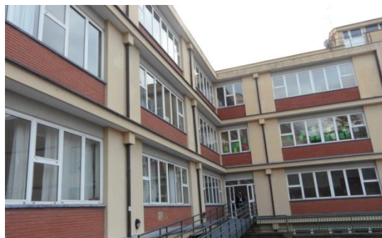
Figura 1.1 - Vista delle facciate esposte a Nord e a Ovest
