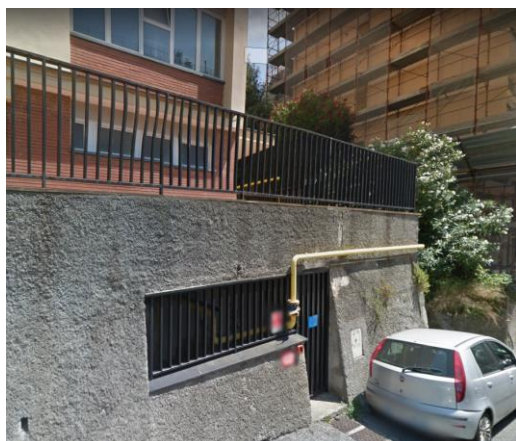
Figura 4.10 - Posizione della Centrale Termica
