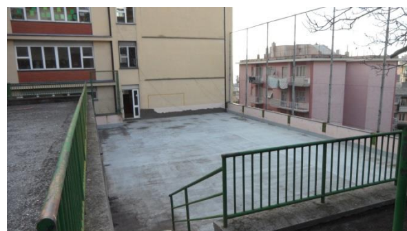
Figura 4.2 - Particolare della copertura della palestra
